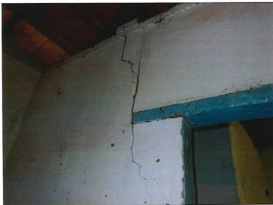
Figura 16 – Rachadura em parede interna da casa.
