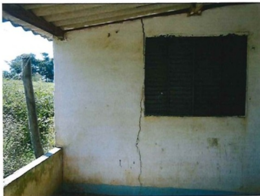
Figura 14 – Rachadura em parede da edificação.
