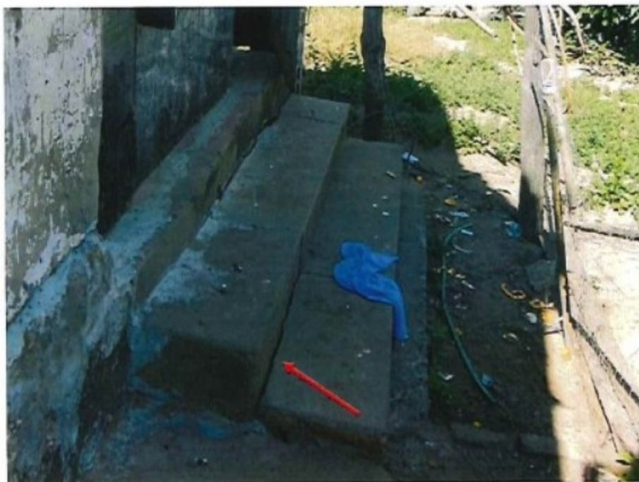
Figura 21 – rachaduras na escada de acesso à área de serviço.
