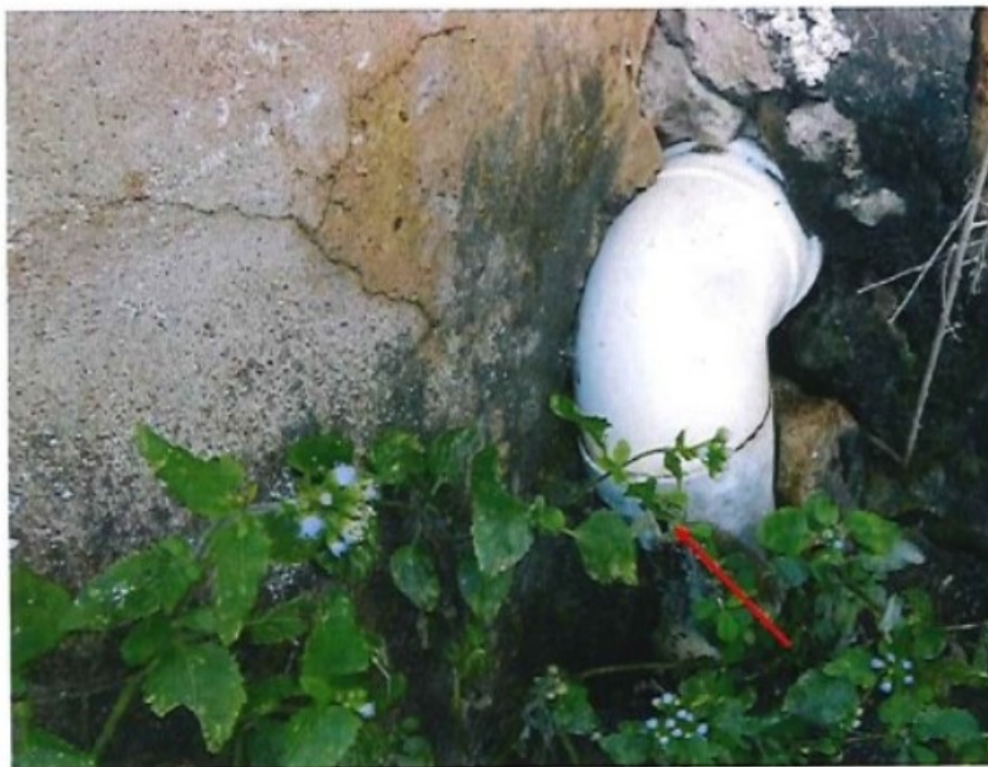
Figura 13 – A seta vermelha indica o ponto de vazamento no encanamento que conduz a água utilizada no vaso sanitário à fossa séptica.
