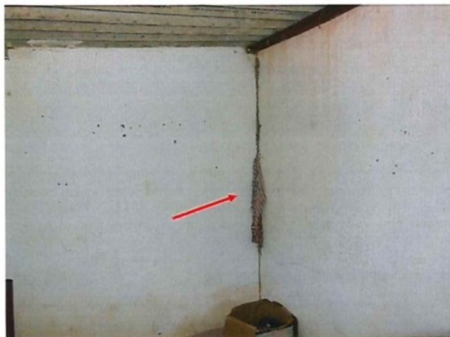
Figura 18 – Em outra rachadura em parede interna, chegou-se a introduzir trapos na abertura, de modo que o ar frio noturno não entrasse no dormitório.
