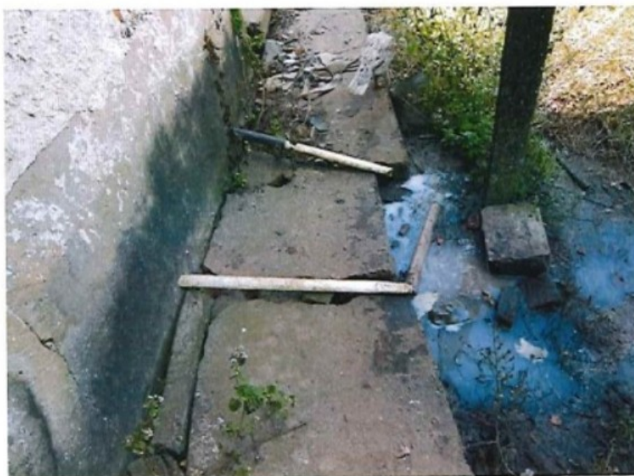
Figura 22 – Encanamento da cozinha e lavanderia sendo despejado no entorno da edificação.
