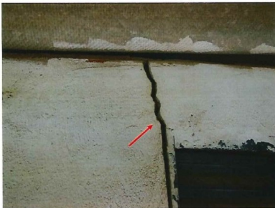
Figura 15 – Detalhe da rachadura vista na foto anterior.
