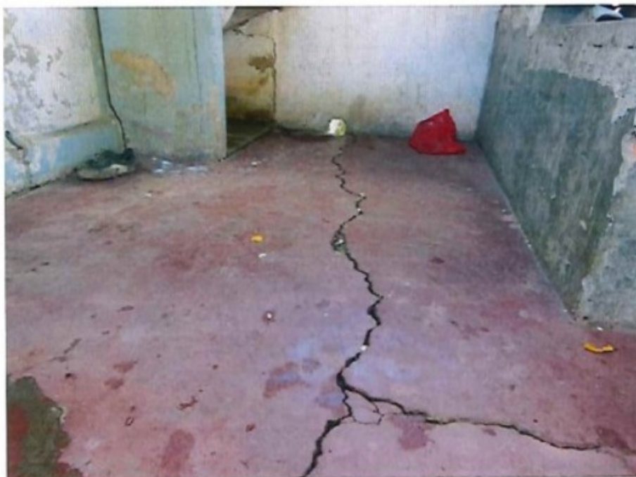
Figura 20 – Rachaduras no piso da área de serviço.
