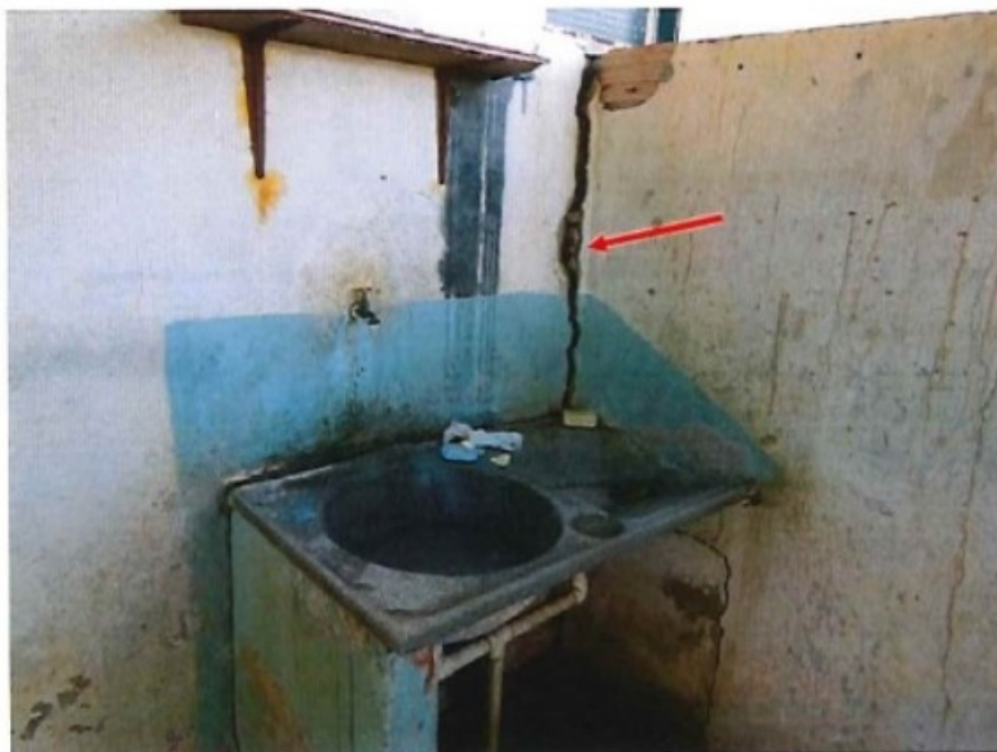
Figura 19 – Rachadura em parede da área de serviço.
