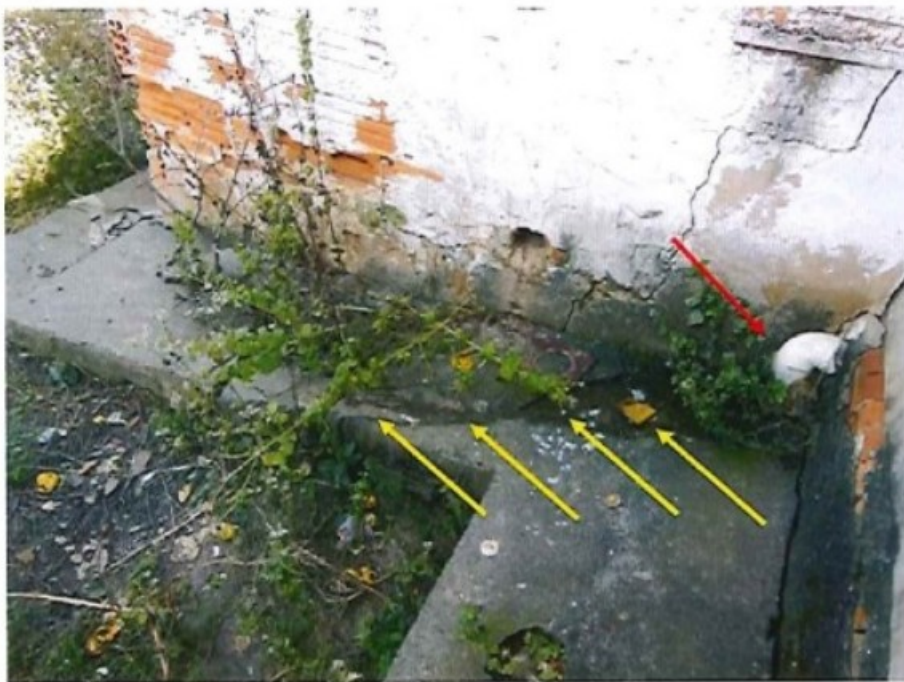
Figura 12 - A seta vermelha indica buraco no encanamento proveniente do vaso sanitário, por onde pôde ser observado vazamento, que escorria, com odor característico, pelo caminho indicado pelas setas amarelas.
