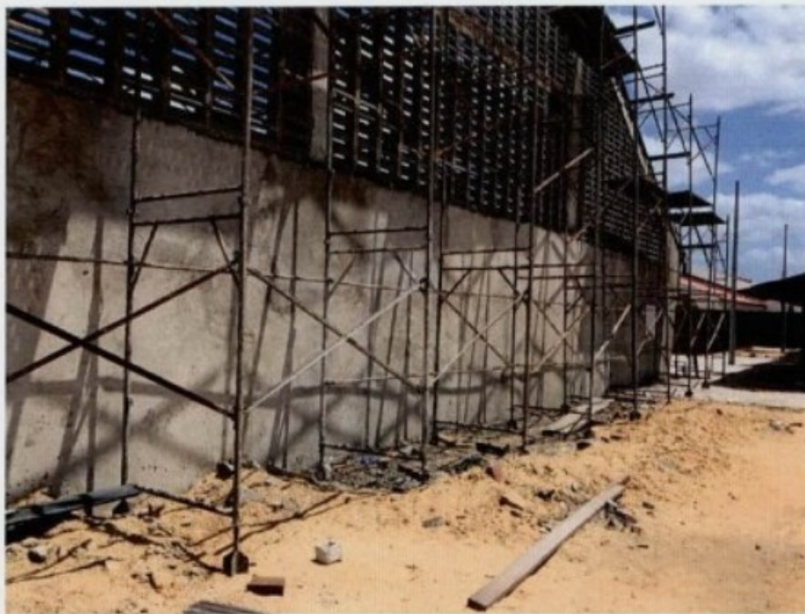
Andaime sem sistema de guarda-corpo e rodapé.
