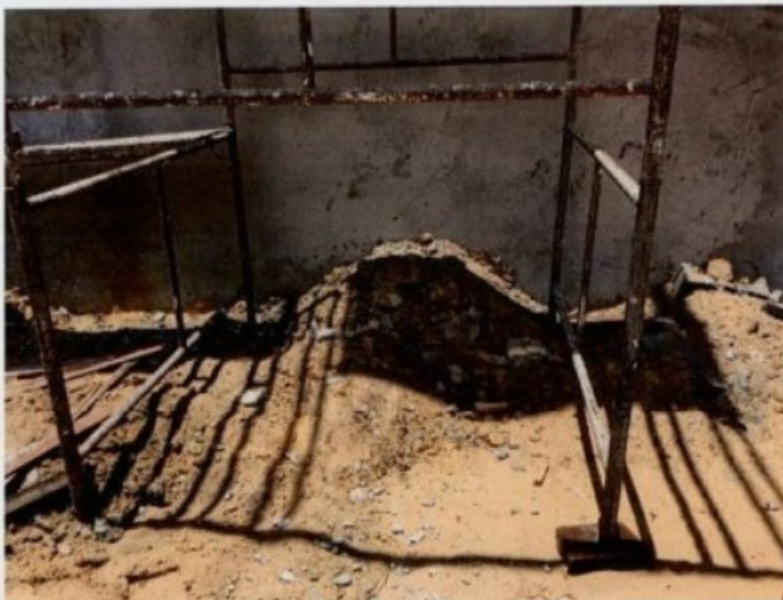
Andaime com fixação inadequada.
