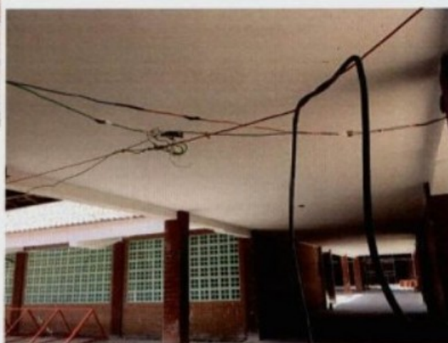
Instalações elétricas com risco de choque elétrico em todo o canteiro de obra.
