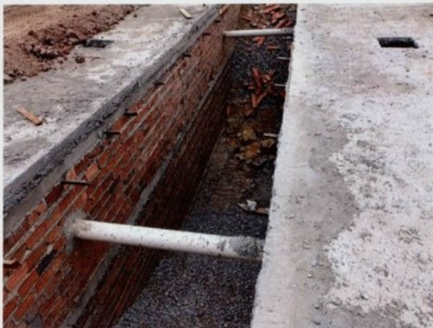
Falta de proteção contra quedas de trabalhadores.
