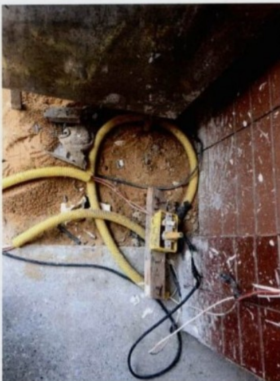
Instalações com risco de choque elétrico espalhadas por todo o canteiro de obras.
