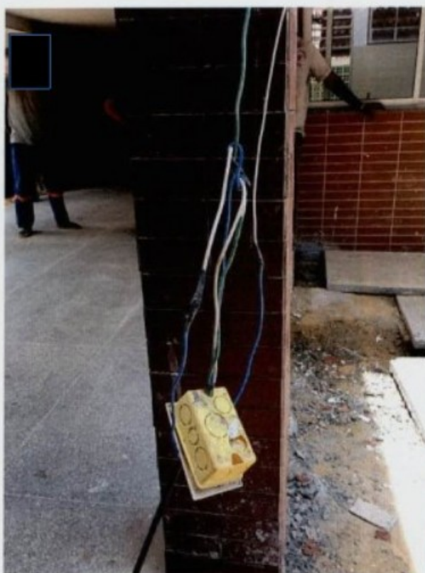
Instalações elétricas com risco de choque elétrico em todo o canteiro de obra.
