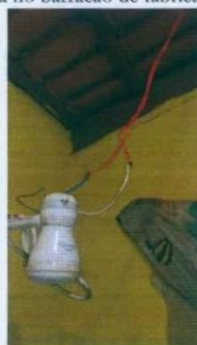
Fiação improvisada em alojamentos inspecionados
