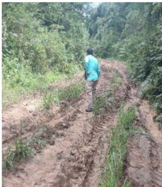
Foto 2: Motorista constatando a impossibilidade de passagem de carros pelo caminho dentro da propriedade.
