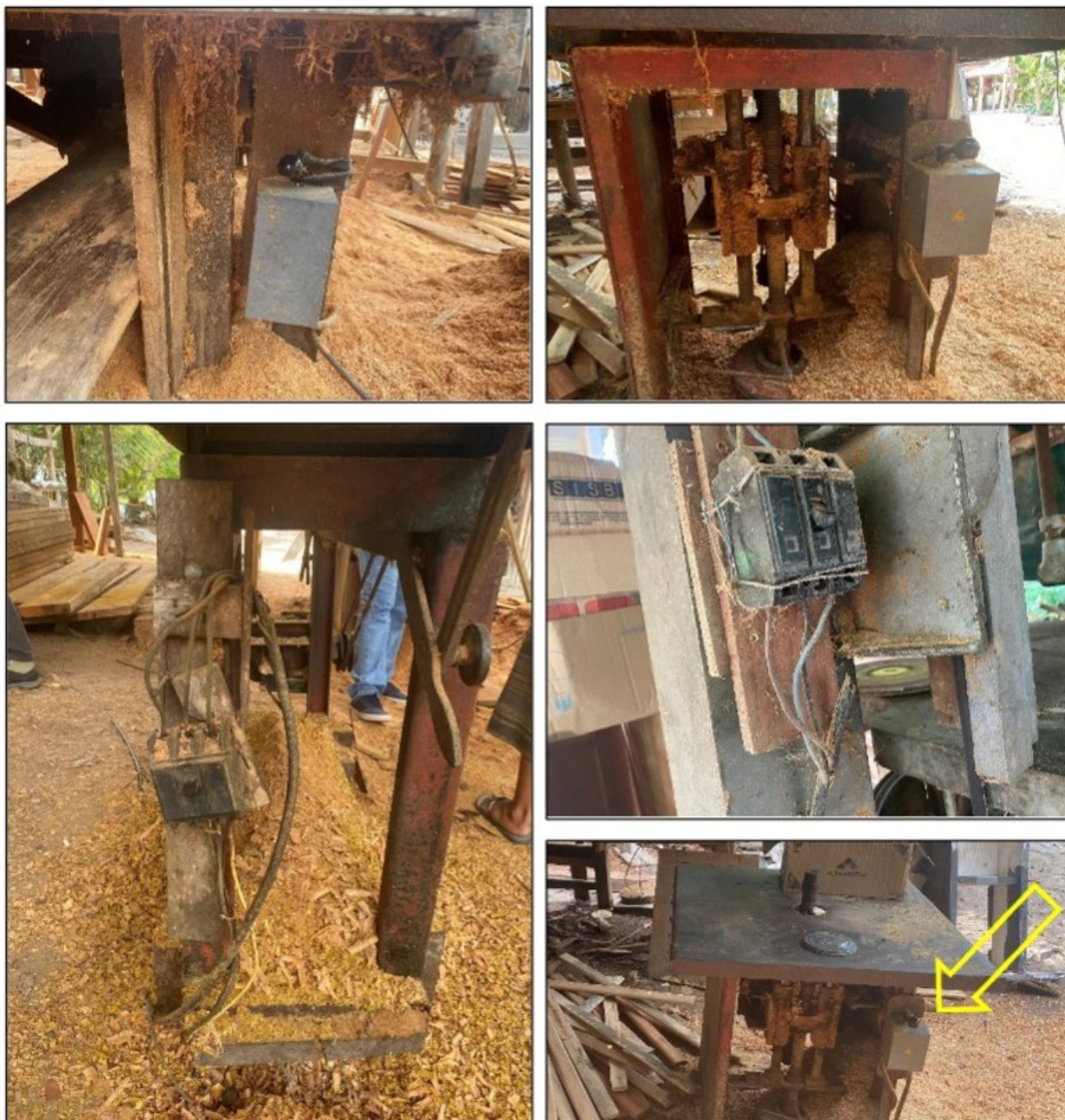
Imagens acima: Disjuntores e chaves tipo Lombard que eram utilizados para acionamento das máquinas.
