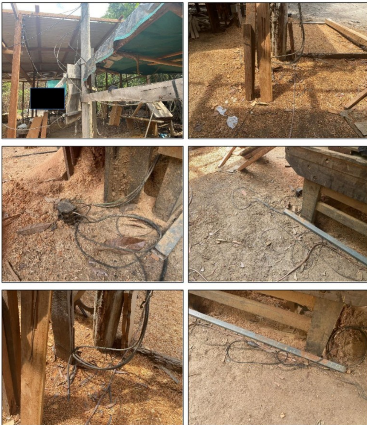
Imagens acima: As instalações elétricas da Fábrica apresentavam riscos de choques e outros acidentes.
