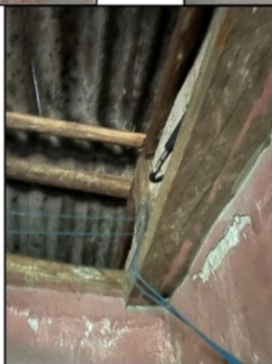
Fotos 30 a 34 – Instalação elétrica improvisada, com partes vivas exposta e com risco de incêndio e choque elétrico.
