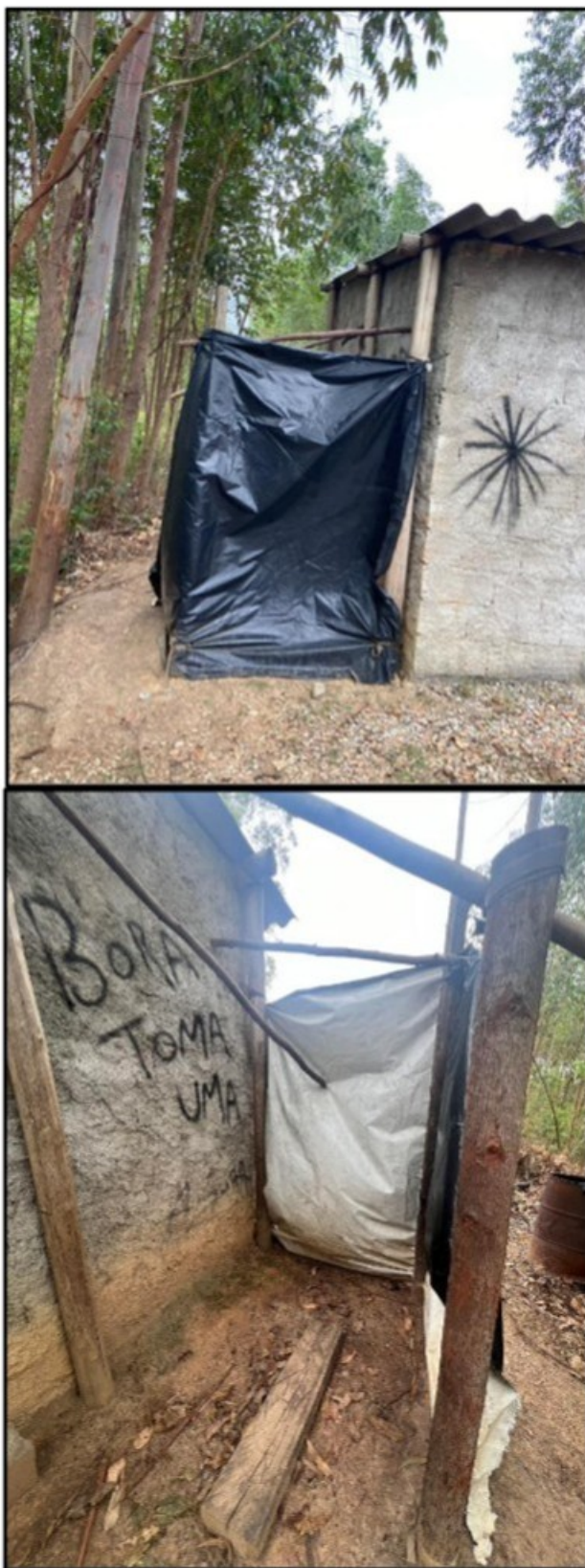
Fotos 66 e 67 – estrutura improvisada utilizada como banheiro, não havia cobertura, iluminação, nem fechamento em todas as laterais.
