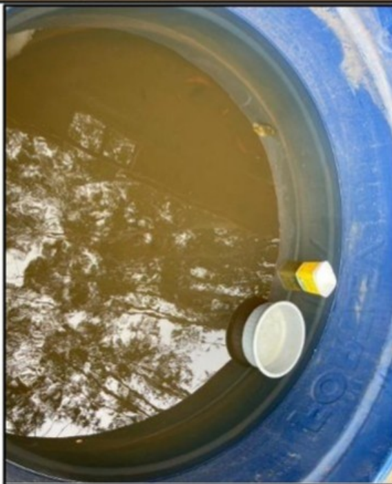
Foto 87 a 89 – Fotos das caixas d'água onde era guardada a água consumida pelos trabalhadores. Verifica-se que a água possui coloração escura e é imprópria para consumo. Verifica-se na segunda imagem uma barata que estava boiando sobre a água da caixa d'água.
