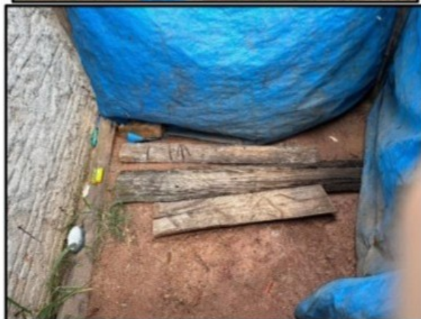
Fotos 10 a 12 - Local improvisado para tomar banho pelas trabalhadoras [REDACTED] e [REDACTED], o local não tinha iluminação e cobertura, nem paredes, laterais feitas de lona.
