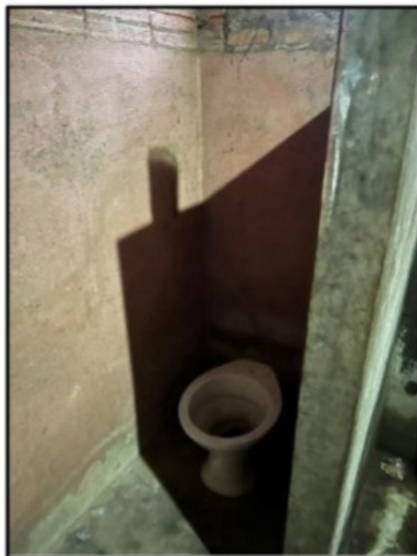
Foto 25 - Outro vaso sanitário deste banheiro, na imagem verifica-se que o vaso sanitário não tinha assento e não era ligado a qualquer rede de água e esgoto, ou seja, foi simplesmente fixado no piso sem a instalação de descarga.
