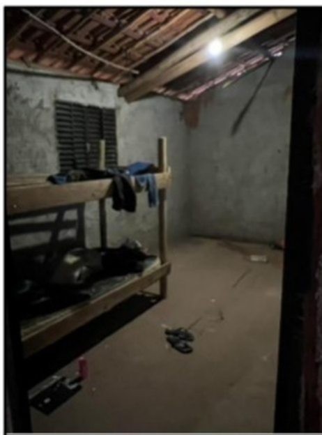
Foto 36 – Foto de um quarto que foi utilizado por um dos trabalhadores. Este trabalhador foi ficar alojado na Fazenda Santa Fé e o quarto não estava sendo utilizado por nenhum dos trabalhadores no momento da inspeção.
