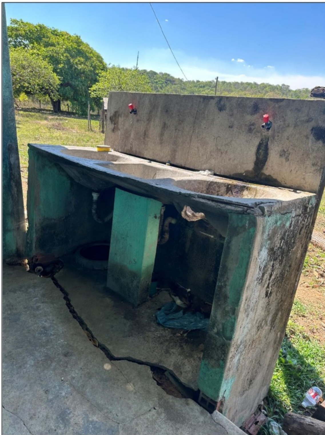
Foto 18: Detalhe da rachadura do piso do tanque de lavar roupas utilizado pelo trabalhador
