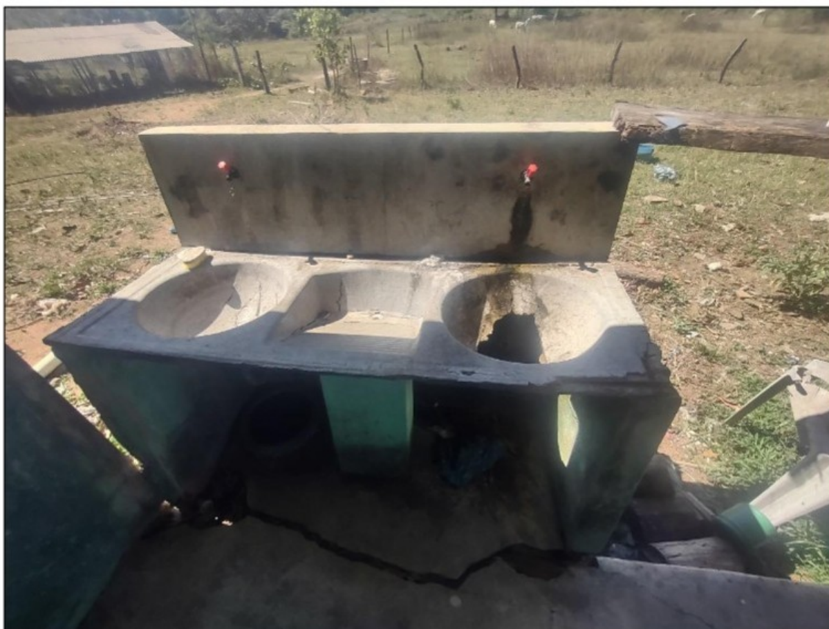
Foto 17: Tanque utilizado pelo trabalhador [REDACTED] O tanque à direita está quebrado, há uma rachadura no piso e o tanque estava quase tombando para trás.
