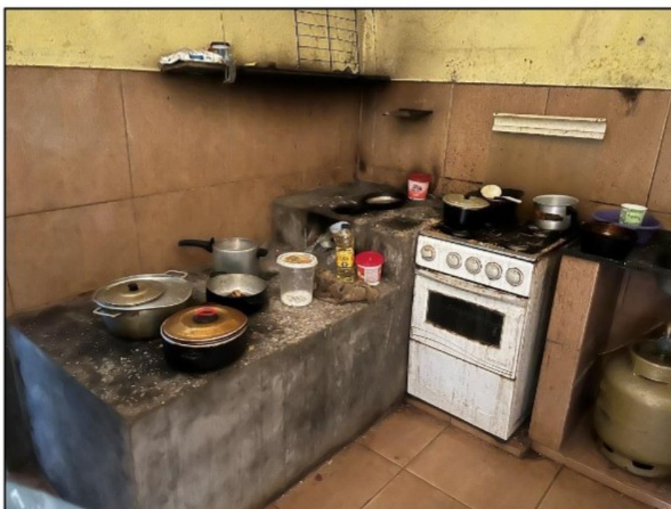
Foto 11 – Fotos do fogão a gás abastecido por um botijão de gás instalado em área interna do alojamento
