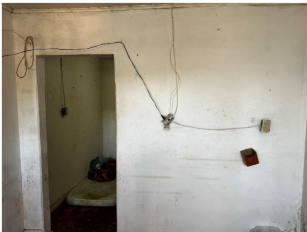
Fotos 40 – Fotos da sala da casa, verifica-se a existência de gambiarras e de fiação elétrica solta.
