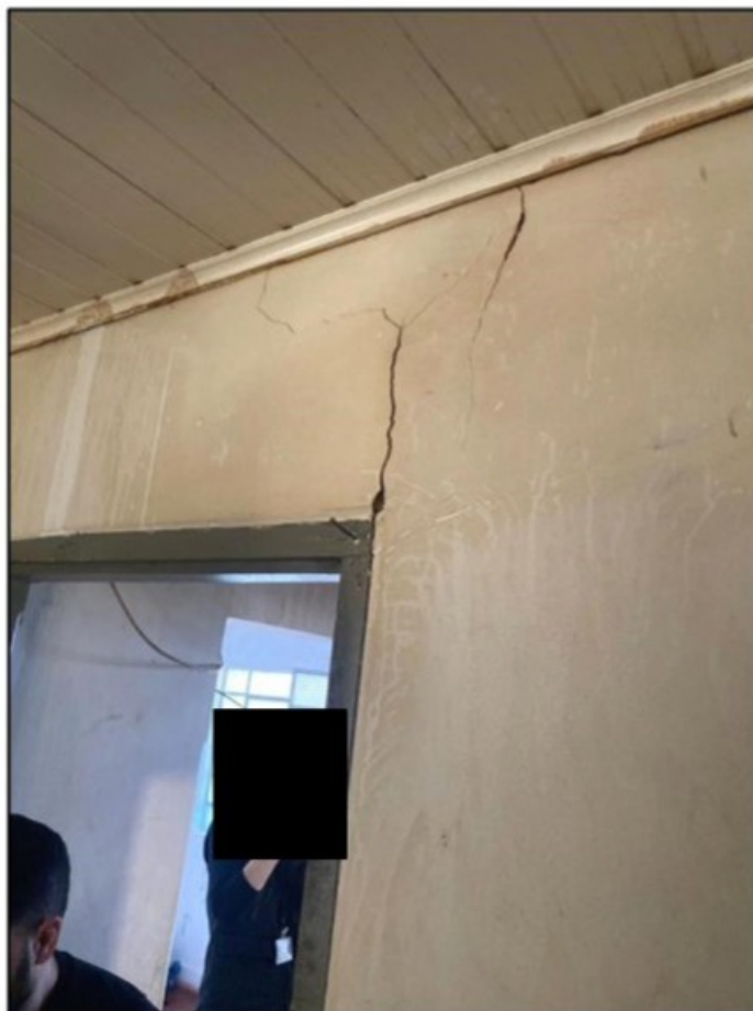
Fotos 54 – Neste cômodo da casa também observamos rachaduras na parede.
