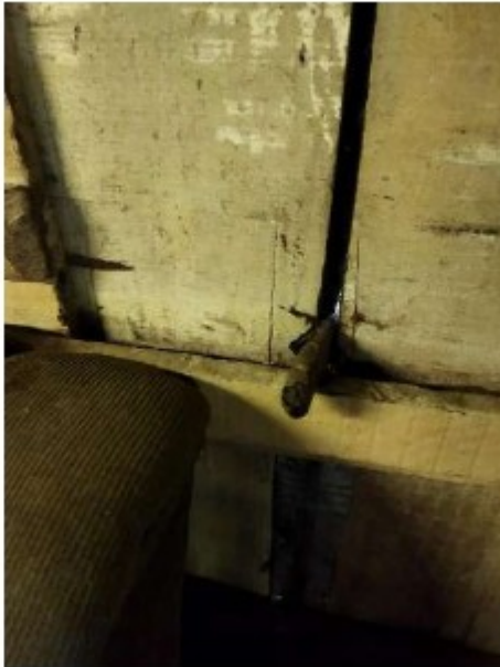
Fechamento da janela com um facão que transpassava a parede.
