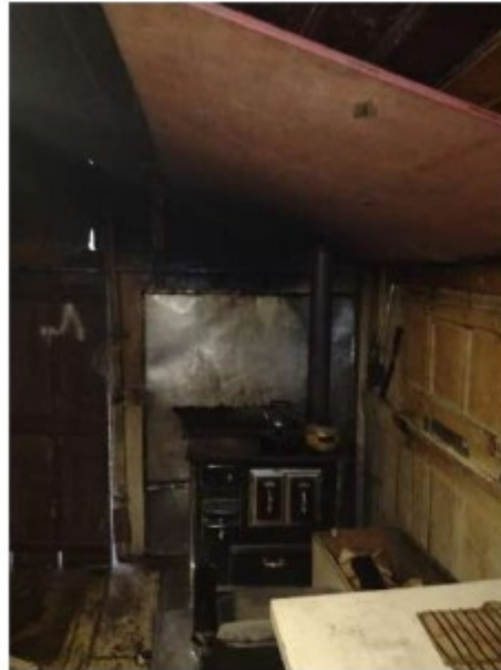
Madeirite colocado no teto da cozinha para fechar os buracos existentes.
