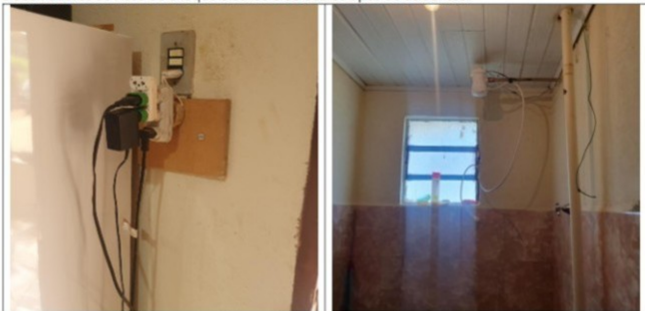
Fotografias das instalações elétricas precárias no alojamento
