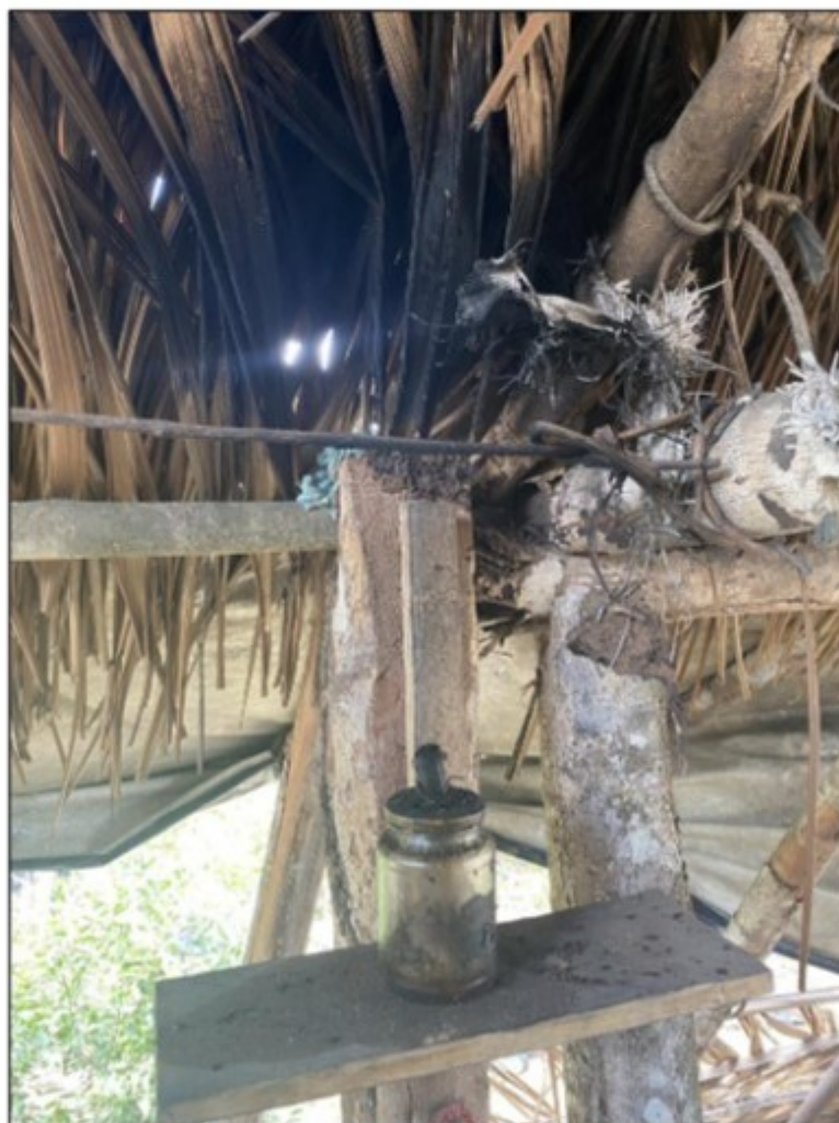
Imagem: Candeeiro que ficava dentro do barraco do casal de trabalhadores da Carvoaria I. Estava bem próximo à cobertura de palhas e lona, deixando-a inclusive empretecida pela ação da fumaça. O risco de incêndio era real e iminente.
