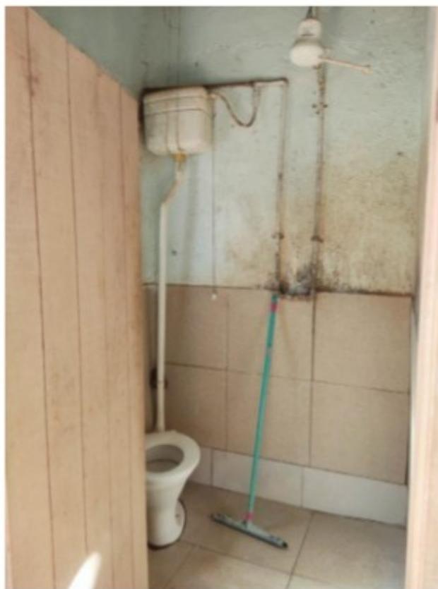
Figura 25 - Segunda instalação sanitária, localizada na extremidade esquerda da frente do alojamento. Dispunha de um vaso sanitário com descarga e chuveiro elétrico, não separados, e lixeira.
