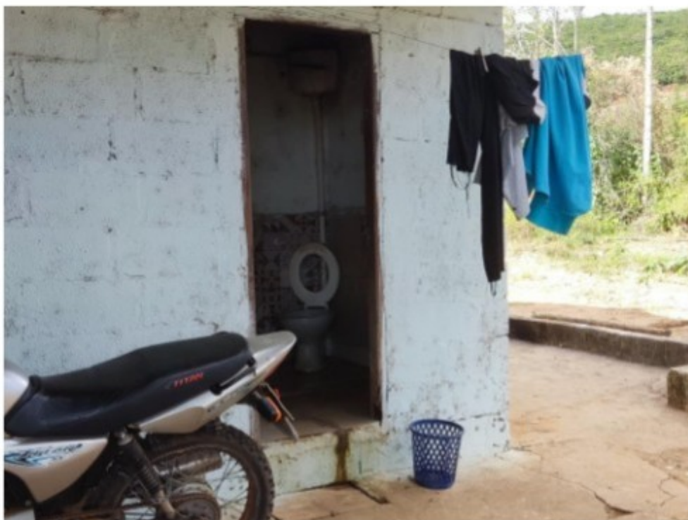
Figura 27 - Terceira instalação sanitária, localizada na extremidade direita da frente do alojamento. Dispunha de um vaso sanitário com descarga que não funcionava e um chuveiro não ligado à rede elétrica.
