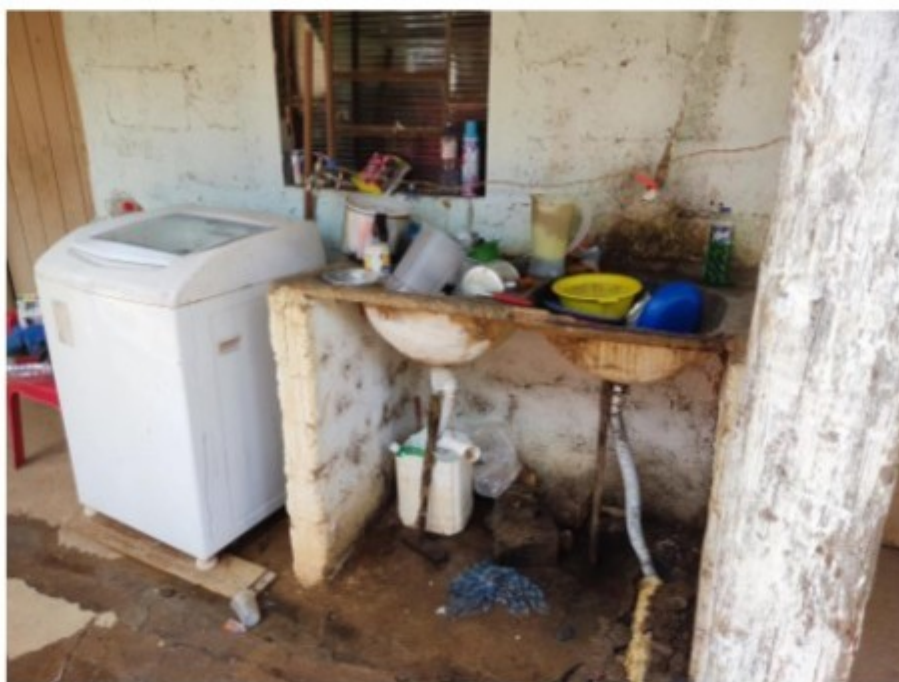
Figura 10 - Utensílios de cozinha sendo lavados em tanque nos fundos do alojamento. Com encanamento quebrado, a água escorria e empoçava no chão.
