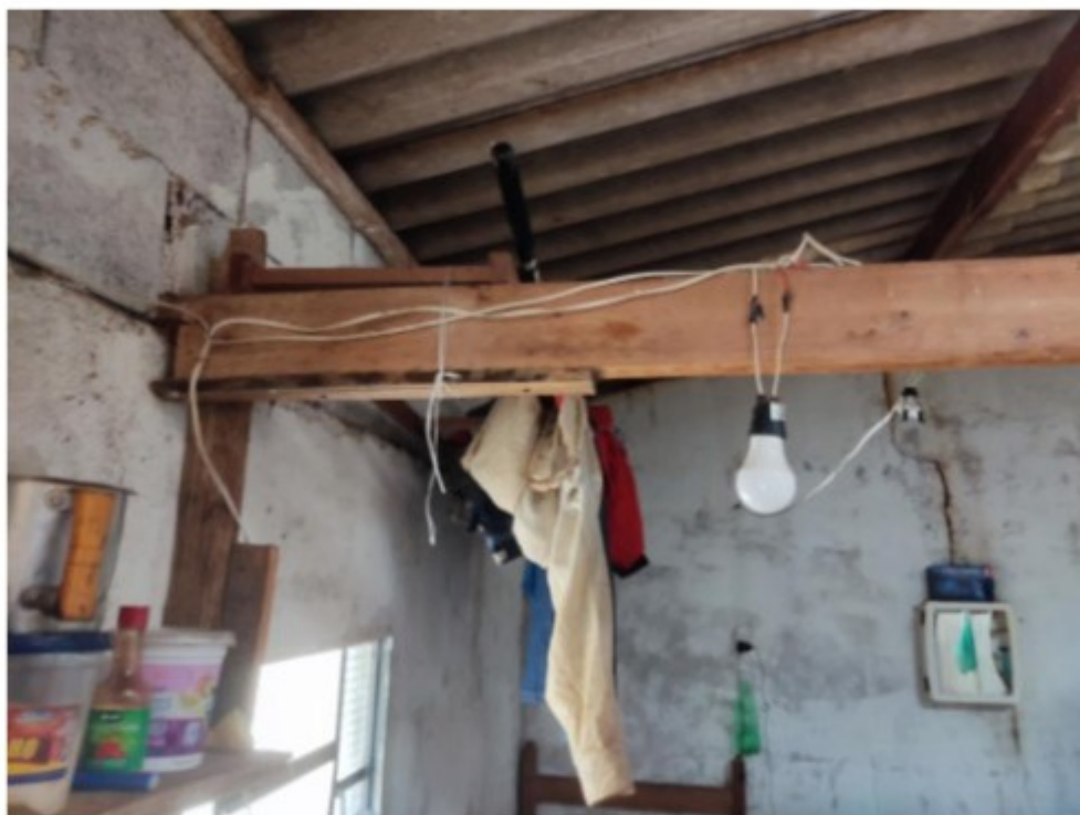
Figura 38 - Instalação elétrica improvisada da iluminação em madeira do telhado no dormitório 6.
