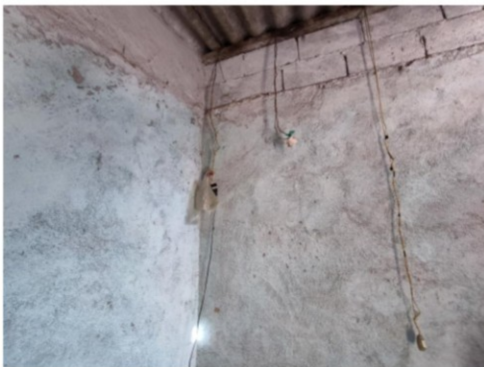
Figura 41 - Condutores elétricos pendendo do telhado no interior do dormitório n. 10.
