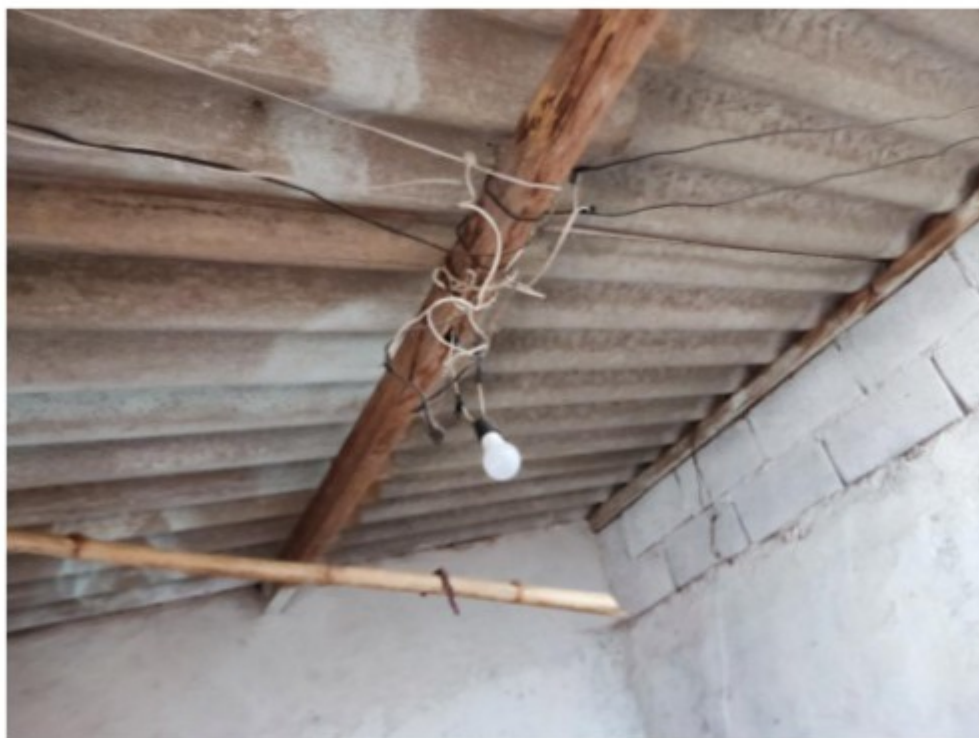
Figura 40 - Emaranhado de condutores elétricos em madeira do telhado no dormitório 7.
