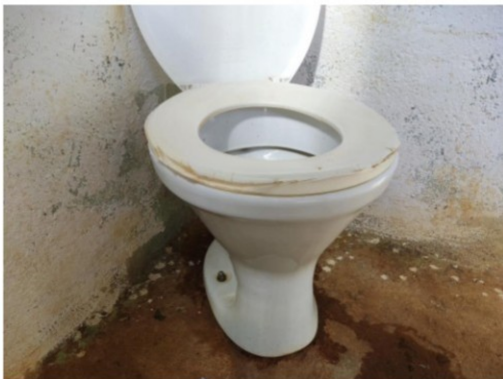
Figura 24 - Na mesma instalação sanitária, assento do vaso sanitário quebrado, o que impede sua higienização adequada.
