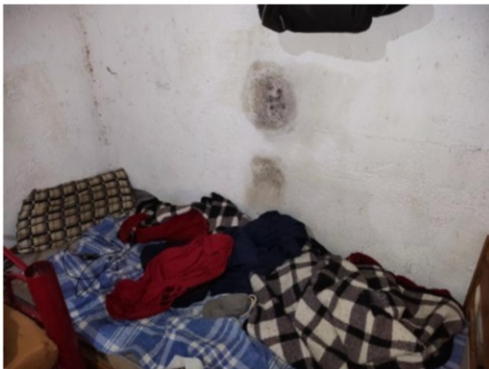
Figura 13 - Parede com mofo, no dormitório 5.
