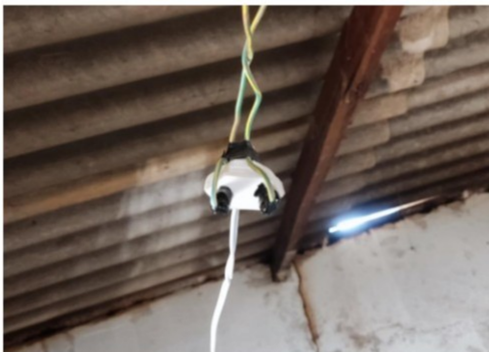
Figura 39 - Detalhe da ligação anterior, que faz uso indevido de plugue.
