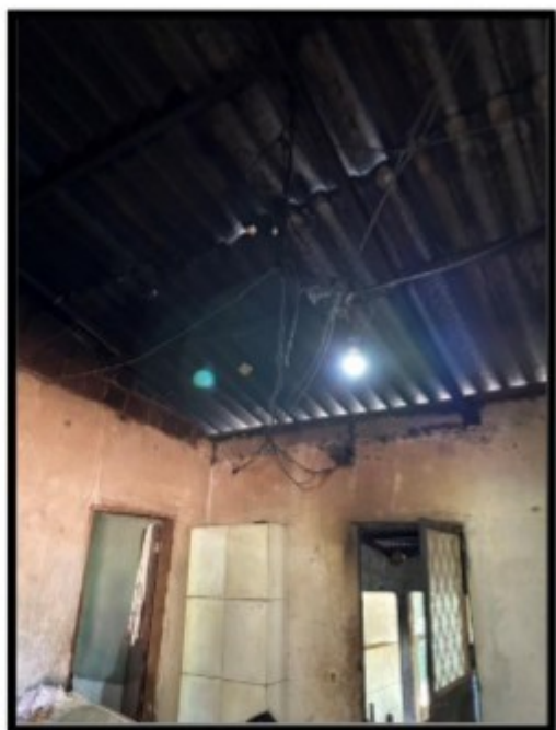
Fotos 5 e 6: Vista do telhado da sala, com sujidade no teto e fios soltos; vista de um dos quartos, com pertences dos trabalhadores espalhados e vitró com vidros quebrados.
