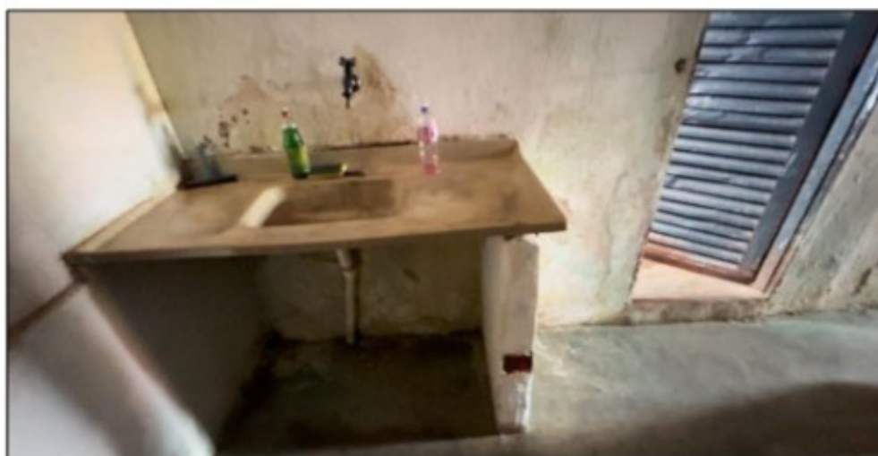
Fotos: Manchas de mofo na parede do local para preparo de refeições, na parte dos fundos do Alojamento 2.
