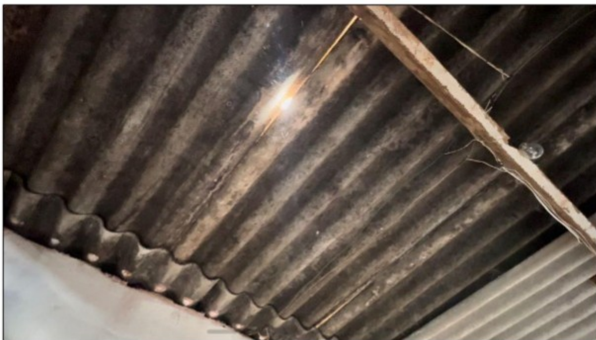
Foto: Deterioramento e manchas de mofo no telhado do dormitório de [REDACTED] com buraco na cobertura.
