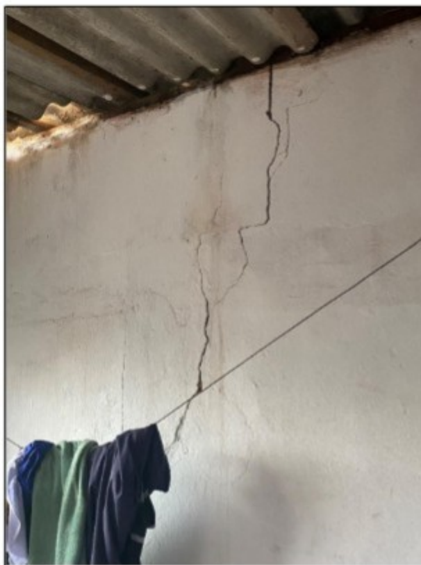
Fotos: Trincas na parede do local para preparo de refeições e em um dos cômodos que era utilizado como dormitório no Alojamento 2.
