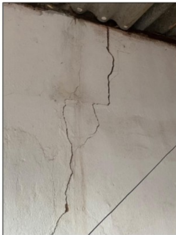
Fotos: Trincas na parede do local para preparo de refeições e em um dos cômodos que era utilizado como dormitório no Alojamento 2.
