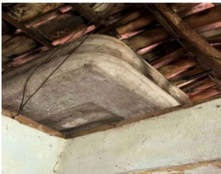
Figura 4: vão entre a parede e o telhado, com caixa d’água destampada apoiada nos caibros do telhado.
