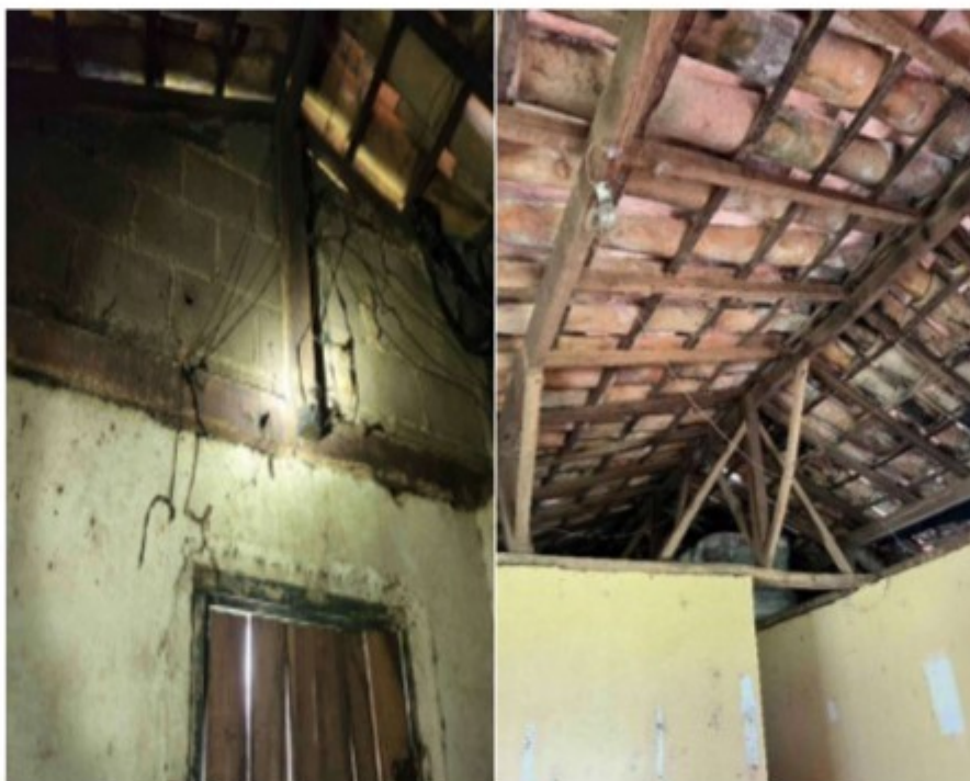
Figura 7: fiação exposta correndo pela parede e por madeira velha; Figura 8: partes vivas próximas à única lâmpada da moradia.
