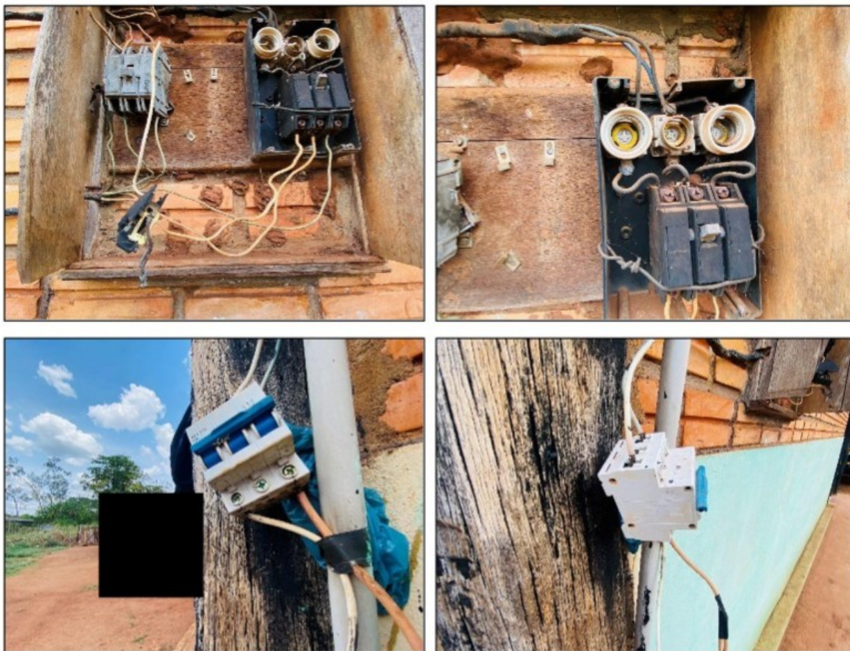
Fotos: Quadro elétrico e fiação desprotegida que ficavam em uma das laterais do alojamento dos trabalhadores.
