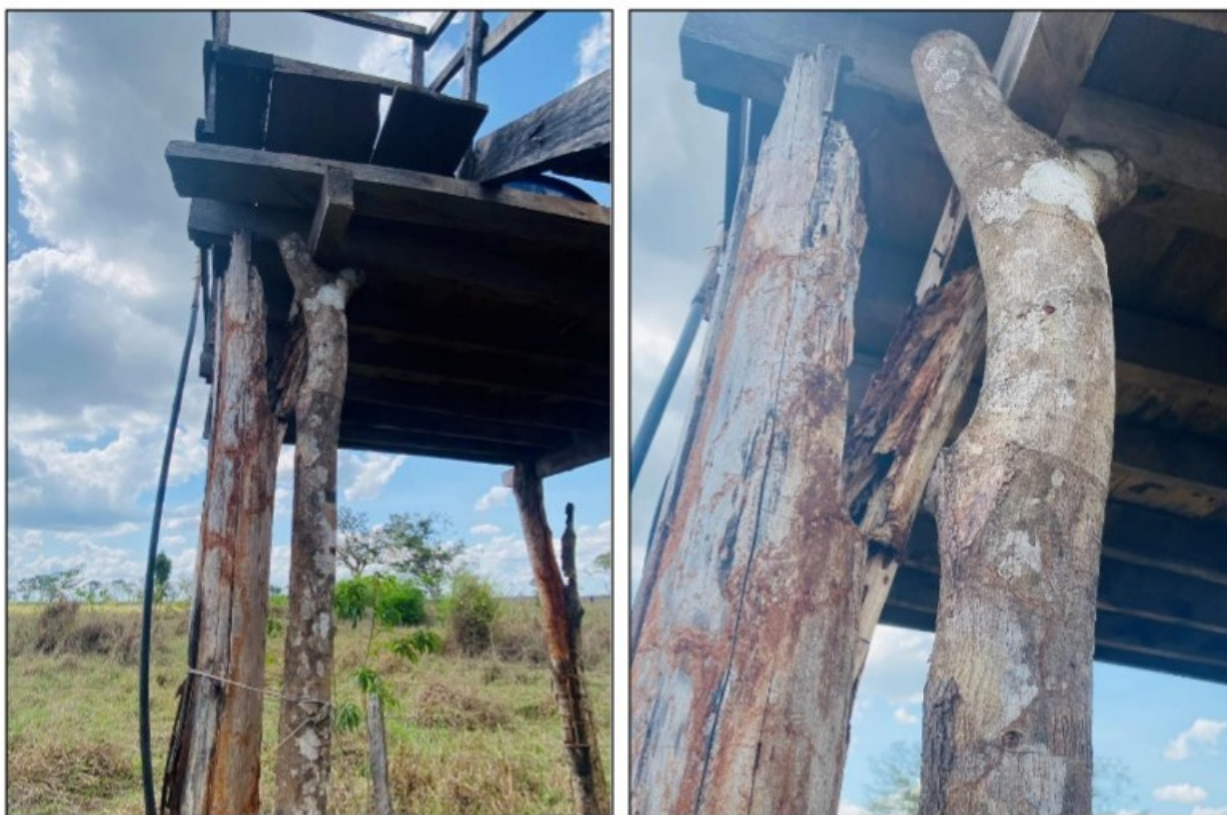
Fotos: Plataforma de madeira que sustentava a caixa d'água. Tinha sido construída de forma improvisada e apresentava problemas estruturais.
