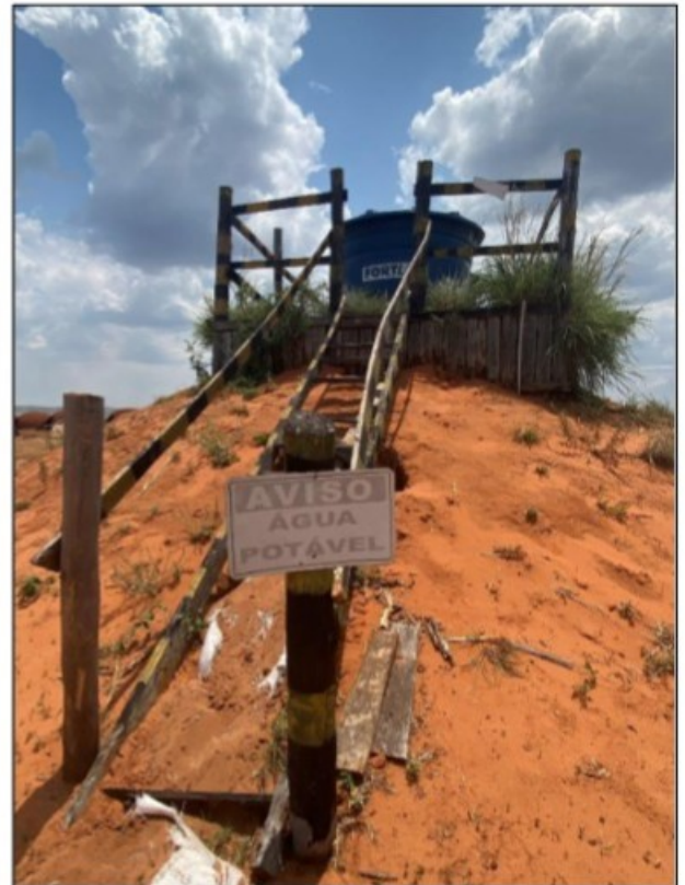
Foto: Escada que dava acesso à plataforma onde ficavam as caixas d'água. Faltavam degraus e não havia guarda-corpo suficientemente capaz de proteger contra quedas.
