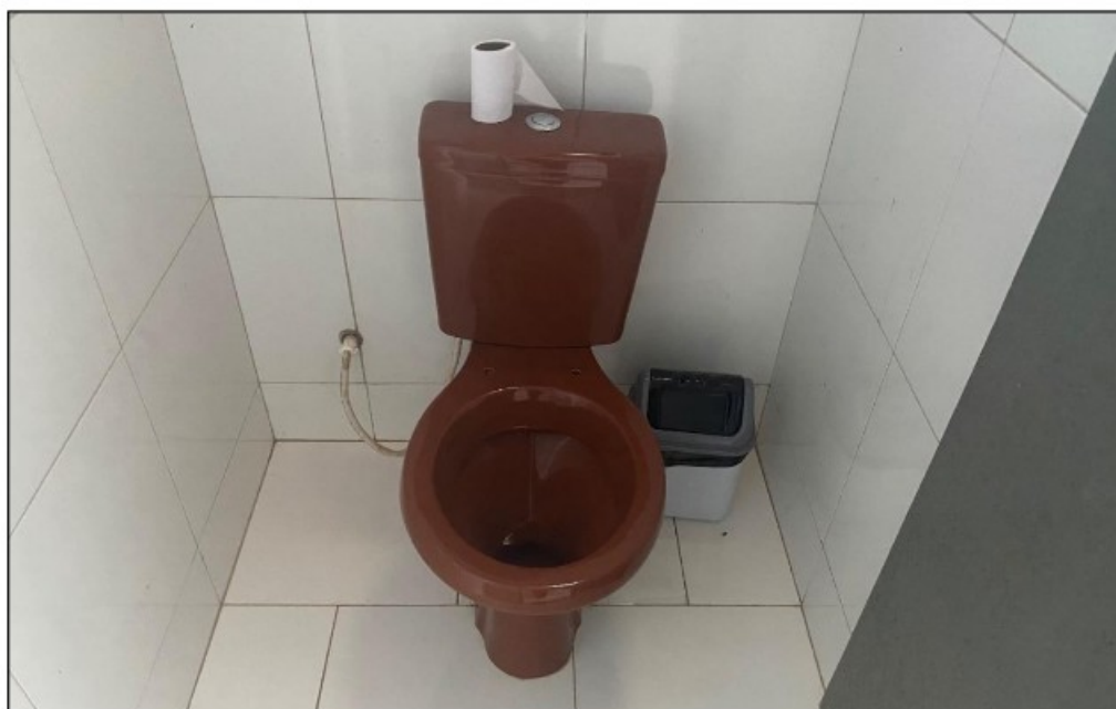
Foto: Vaso sanitário que não era dotado de assento com tampo.
