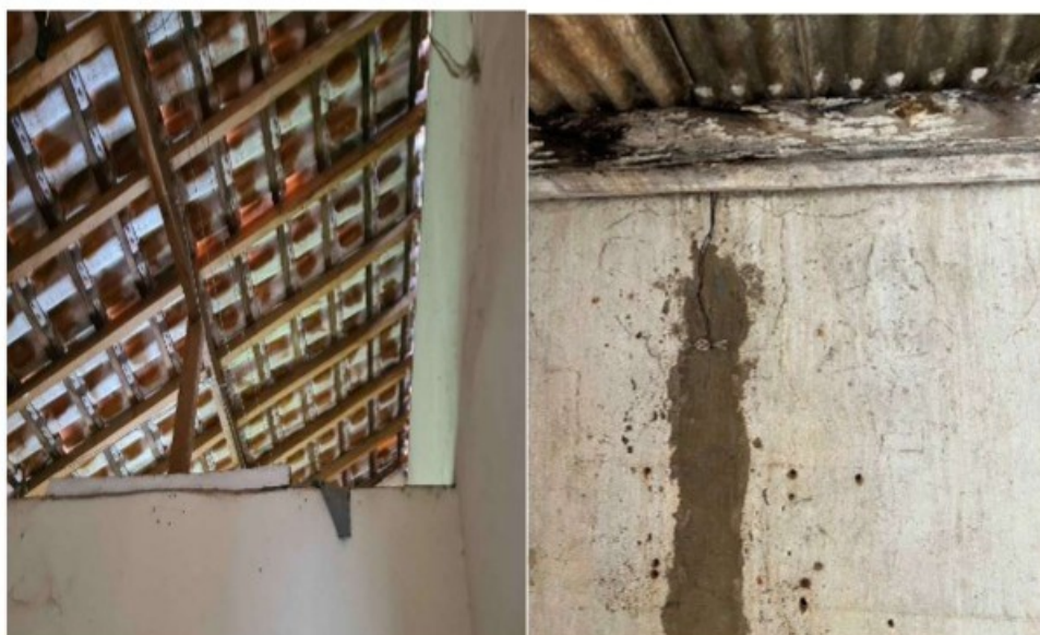
Figura 3: ausência de forro no alojamento desocupado; Figura 4: parede com diversas rachaduras nesse alojamento.
