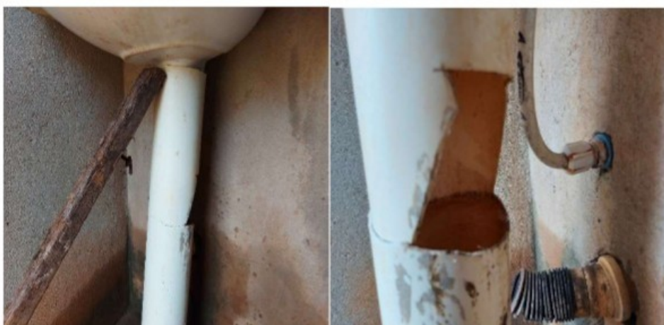
Figuras 8 e 9: pia sem sustentação adequada e cano quebrado.
