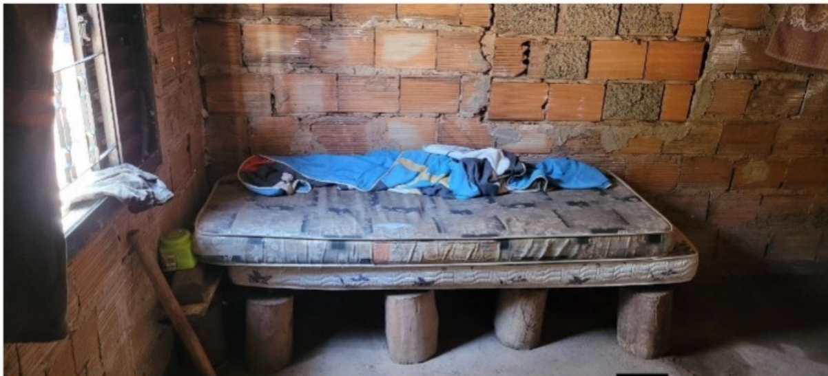
Foto 14. Vista interna do segundo cômodo da edificação mais próxima dos fornos. [REDACTED] tinha que dormir em um colchão colocado sobre um estrado que estava apoiado sobre tocos de madeira Registro efetuado em 08/03/2022.
