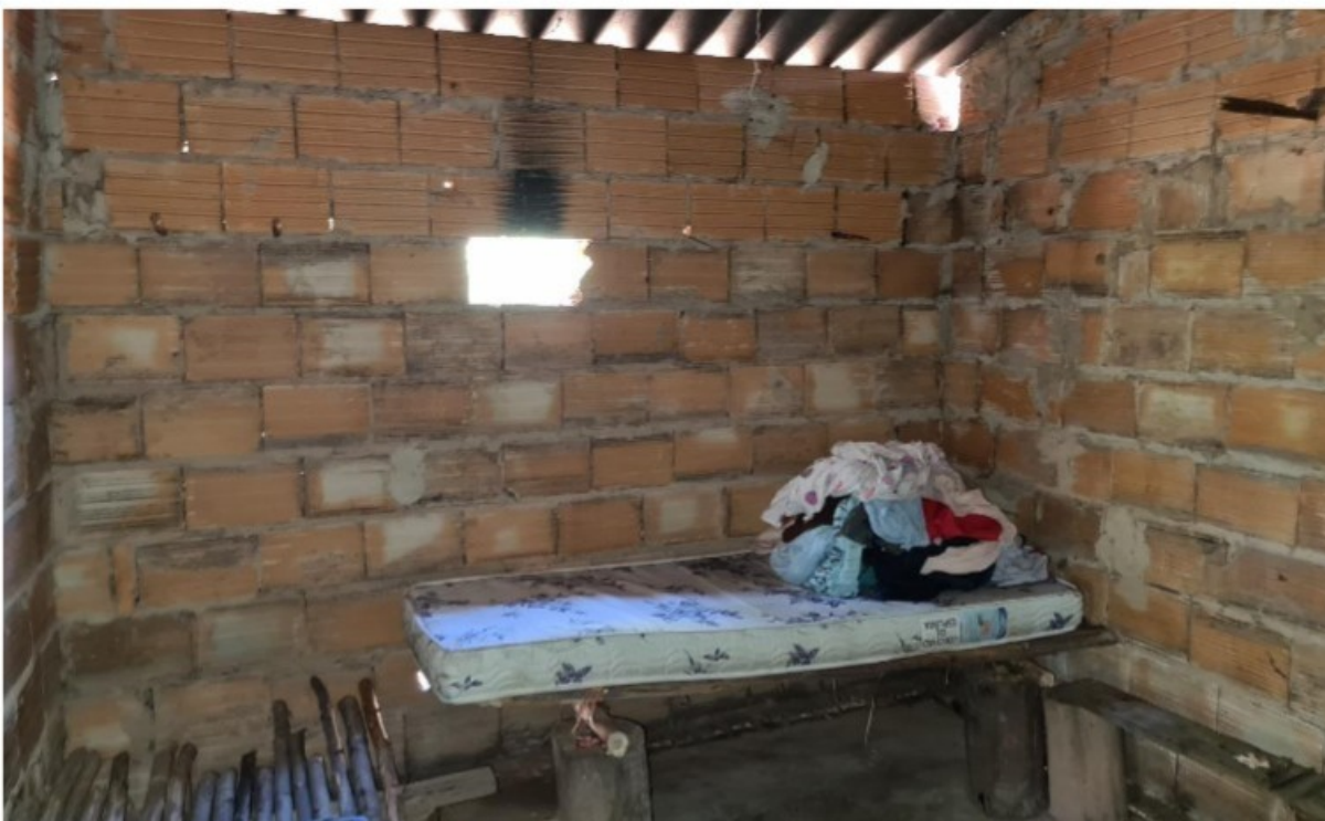
Foto 12. Vista interna do primeiro cômodo da edificação mais próxima dos fornos. Registro efetuado em 08/03/2022.
