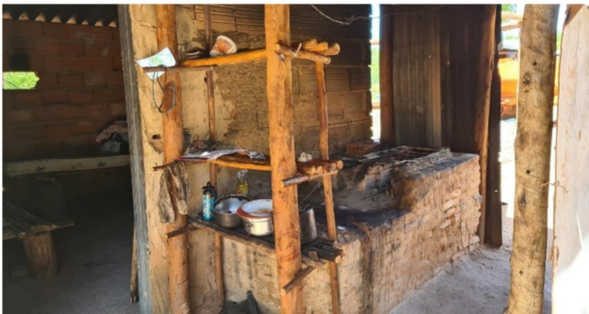
Foto 15. Vista externa da edificação mais próxima dos fornos. No local havia sido improvisado um fogão à lenha. Registro efetuado em 08/03/2022.
