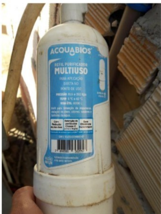
Foto 38: Filtro utilizado no bebedouro, sem eficiência bacteriológica.
