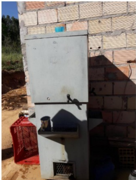
Foto 38: Filtro utilizado no bebedouro, sem eficiência bacteriológica.
