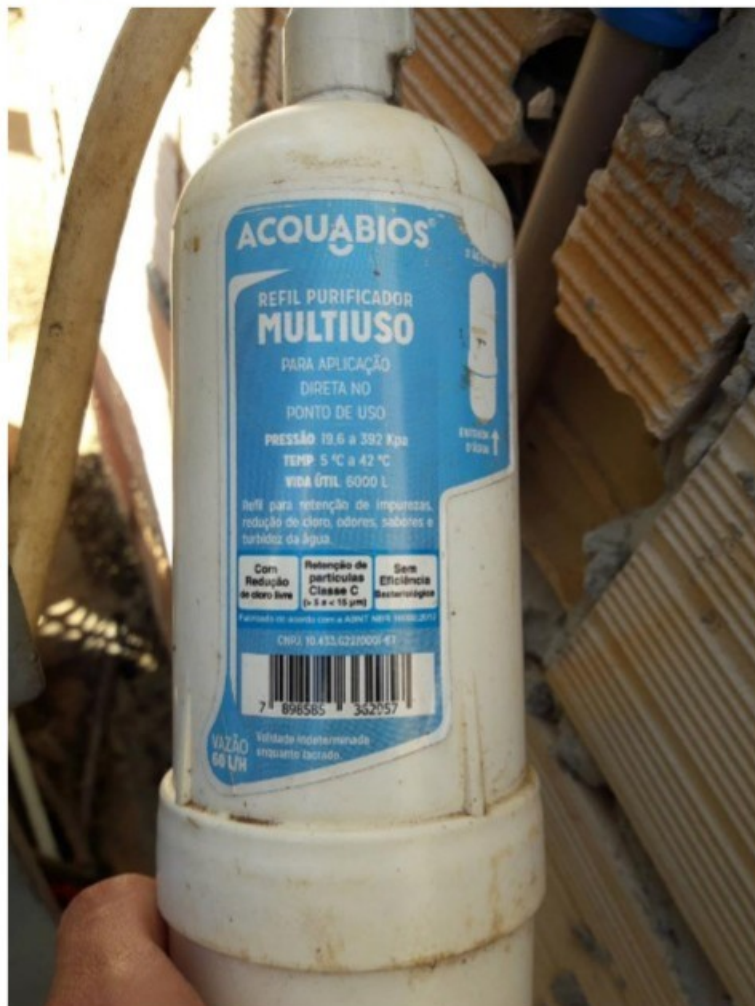
Foto 15: Filtro utilizado no bebedouro, sem eficiência bacteriológica.
