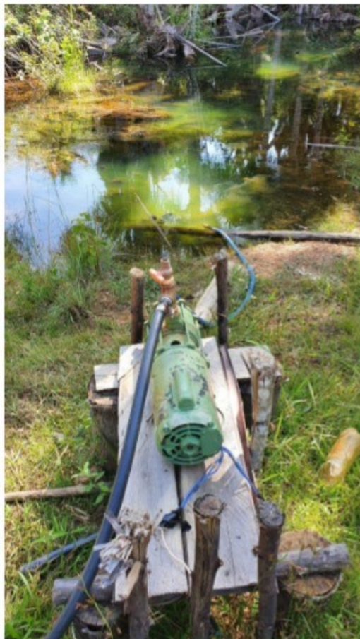
Foto 34: Ponto de captação da água – detalhe para a quantidade matéria orgânica.
