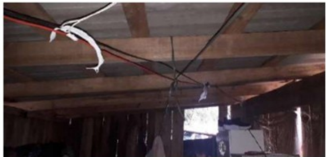
Instalações elétricas precárias.
