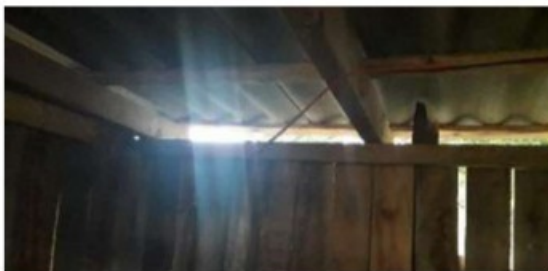
Grandes frestas entre as tábuas que formavam as paredes e entre estas e o telhado, do local usado como dormitório.
