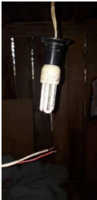
Instalações elétricas precárias.
