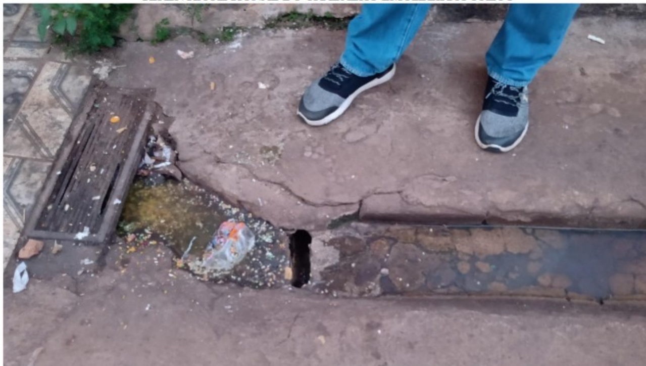
Esgoto aflorando no pátio em frente ao Alojamento 1
