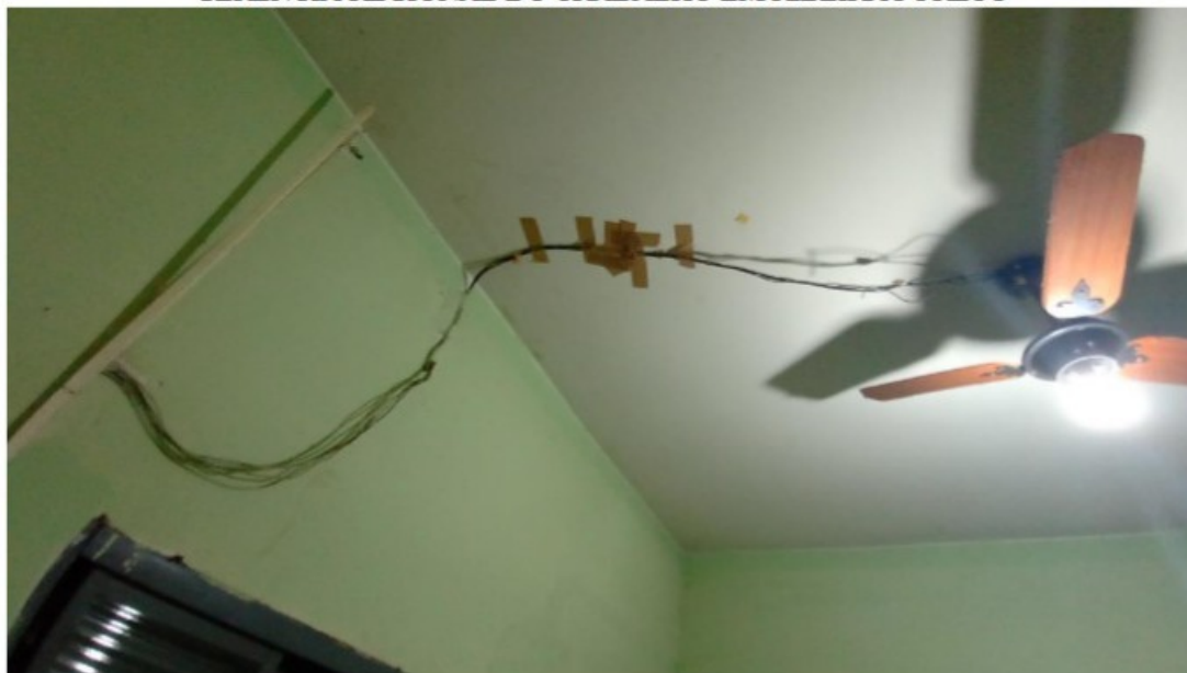
Instalações Elétricas precárias
