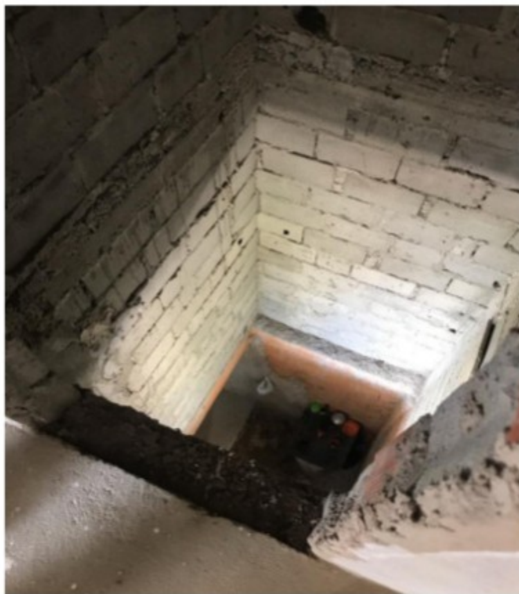
Foto 13 – Caixa de elevador sem fechamento provisório
