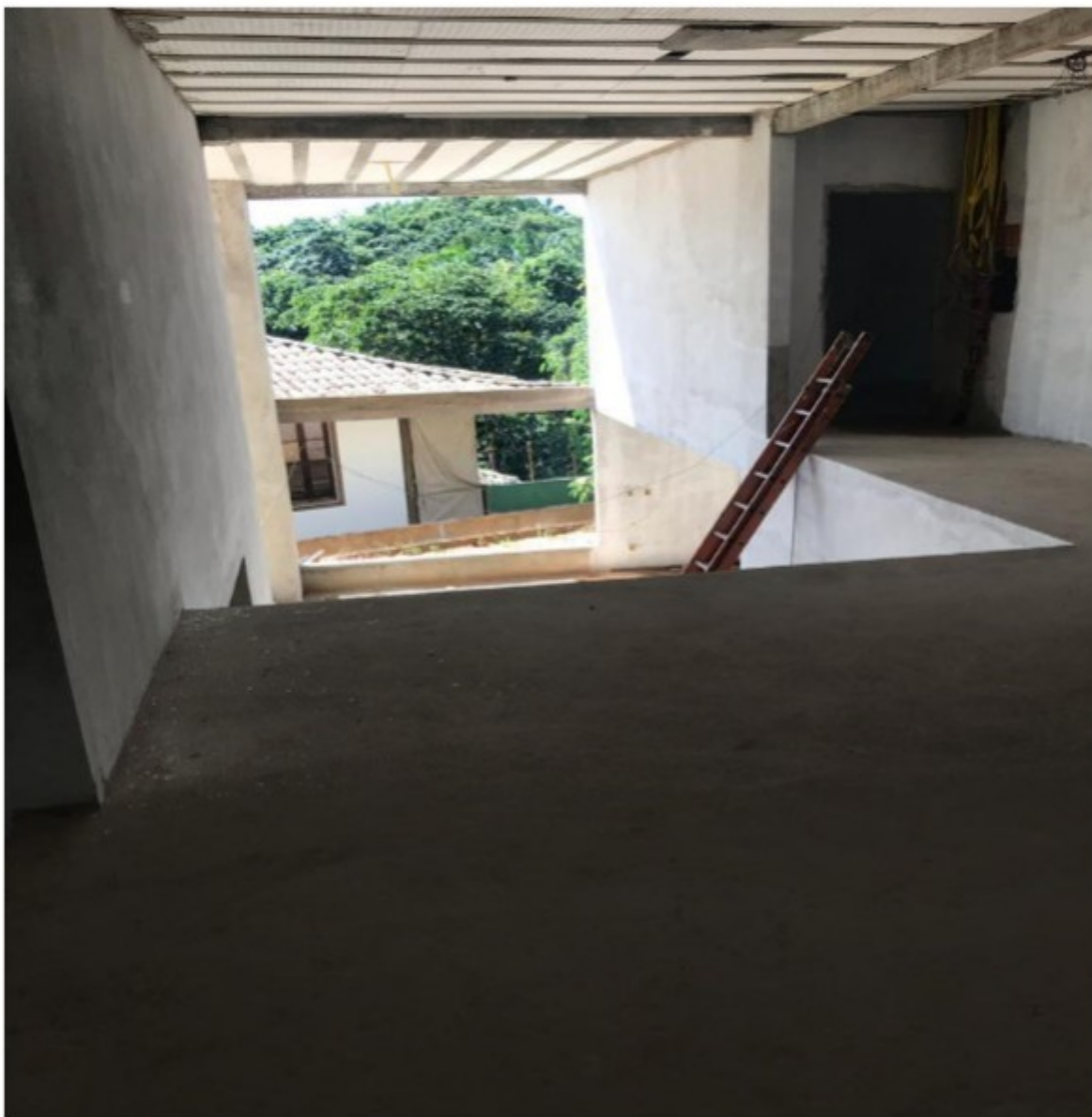
Foto 11 - Área interna da residência em construção sem proteção coletiva
