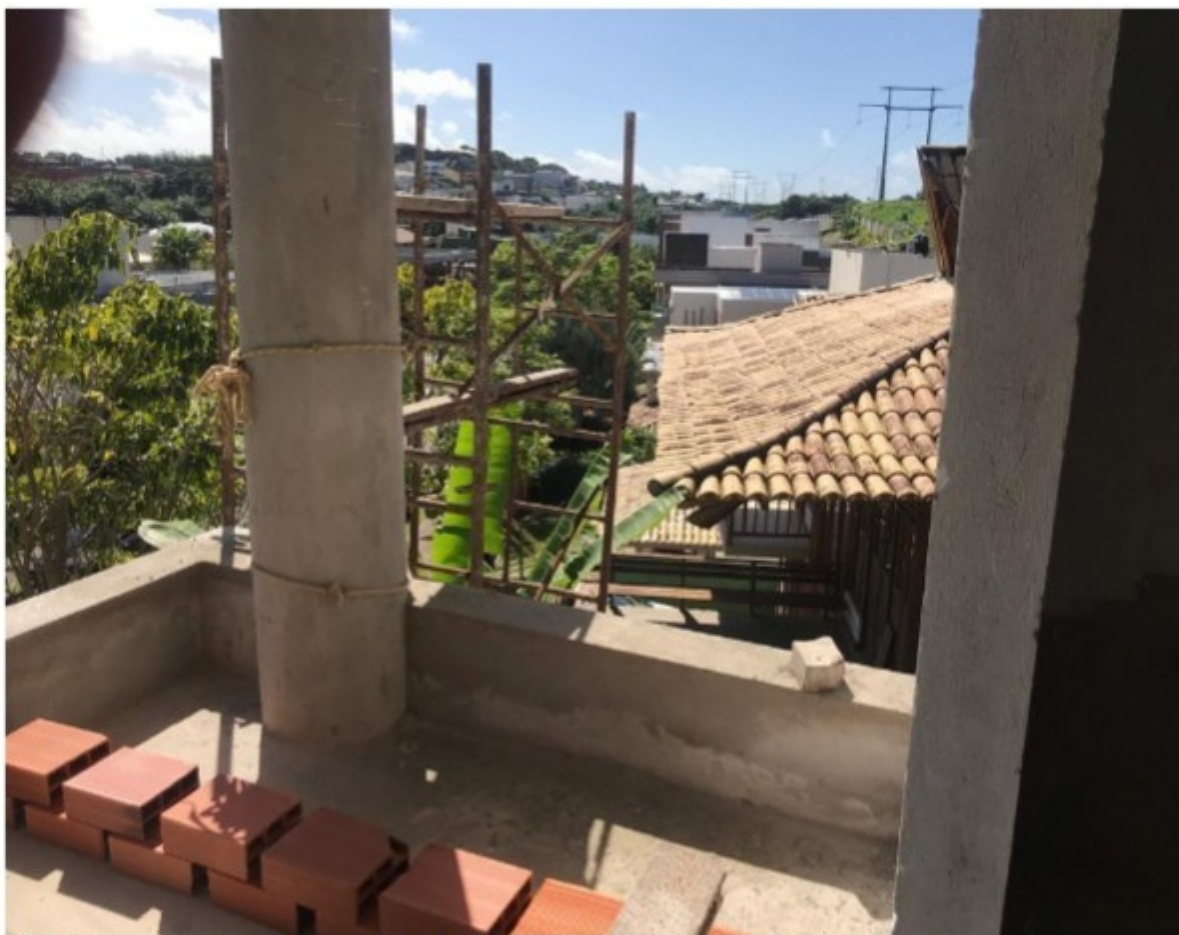
Foto 15 – Andaime preso na estrutura da construção com corda de forma improvisada.
