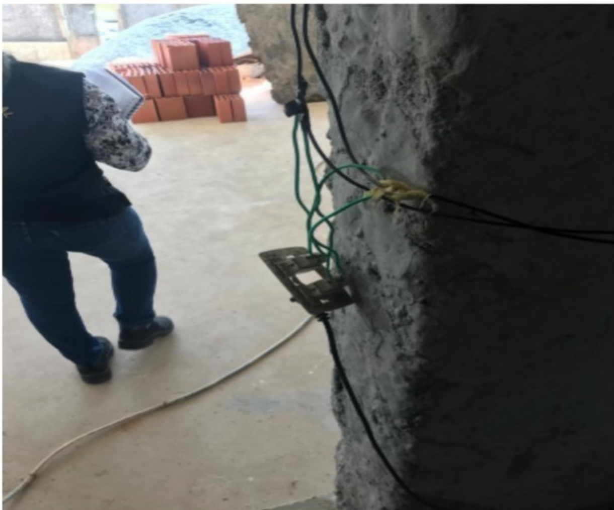
Foto 7- Cabos elétricos expostos com emendas precárias
