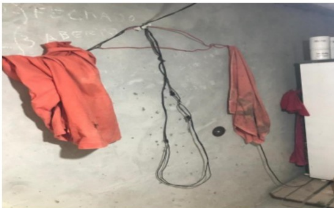
Foto 5 - Cabos elétricos precário e improvisado instalados na cozinha improvisada.
