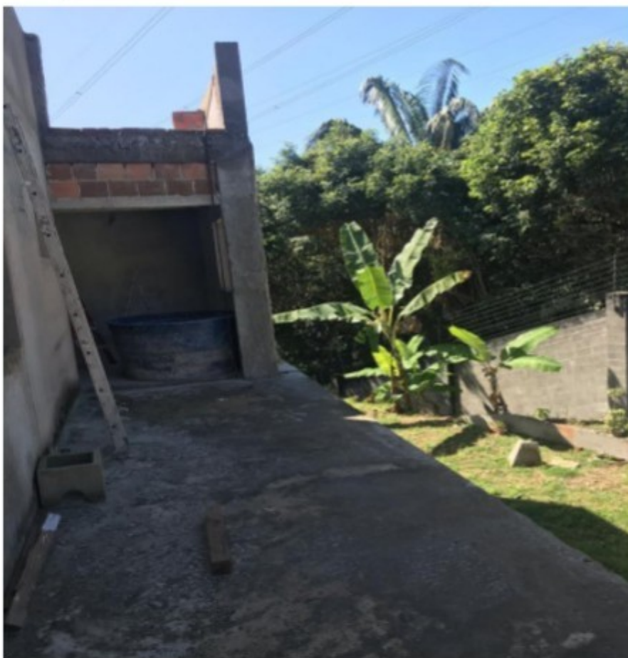
Foto 10 - Sacada do fundo da construção sem proteção coletiva
