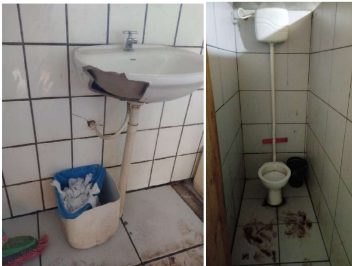
A ausência de pias em bom estado e a falta de assentos nos vasos sanitários constituíram mais um exemplo da falta da adequada conservação do alojamento destinado aos empregados do empregador fiscalizado
