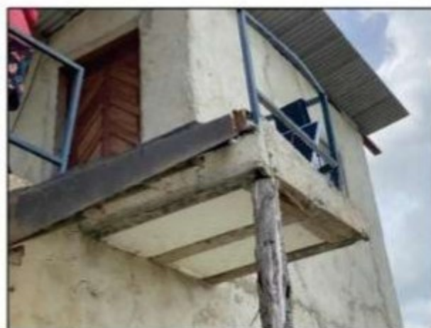
Imagens: Escada de acesso ao local onde os empregados brasileiro almoçavam. Não havia guarda-corpo ou qualquer proteção em sua periferia. A plataforma de acesso ao parte superior da escada estava escorada com tronco de madeira fino e deteriorado.
