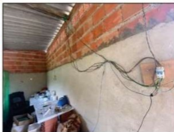
Imagens: Fiação elétrica do local de preparo de rações. Os fios estavam emaranhados e com algumas partes desprotegidas.
