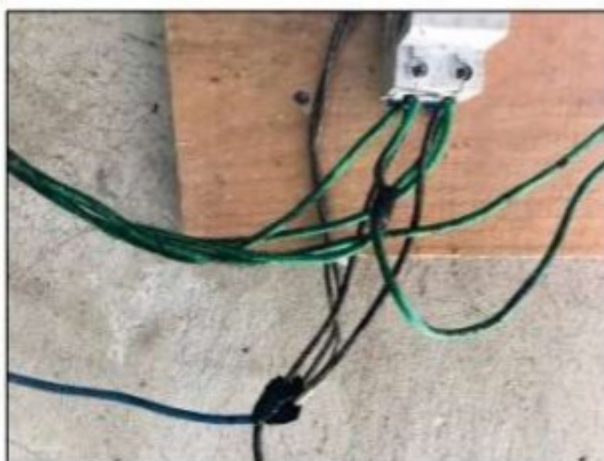
Imagens: Fiação elétrica do local de preparo de rações. Os fios estavam emaranhados e com algumas partes desprotegidas.
