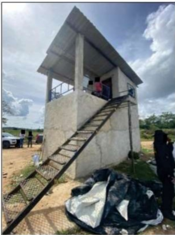
Imagens: Escada de acesso ao local onde os empregados brasileiro almoçavam. Não havia guarda-corpo ou qualquer proteção em sua periferia. A plataforma de acesso ao parte superior da escada estava escorada com tronco de madeira fino e deteriorado.
