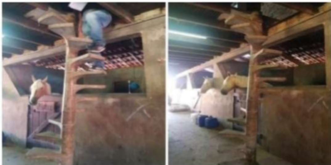
Foto 20 e 21: Vista inferior da escada de acesso ao local onde dormiam os trabalhadores
