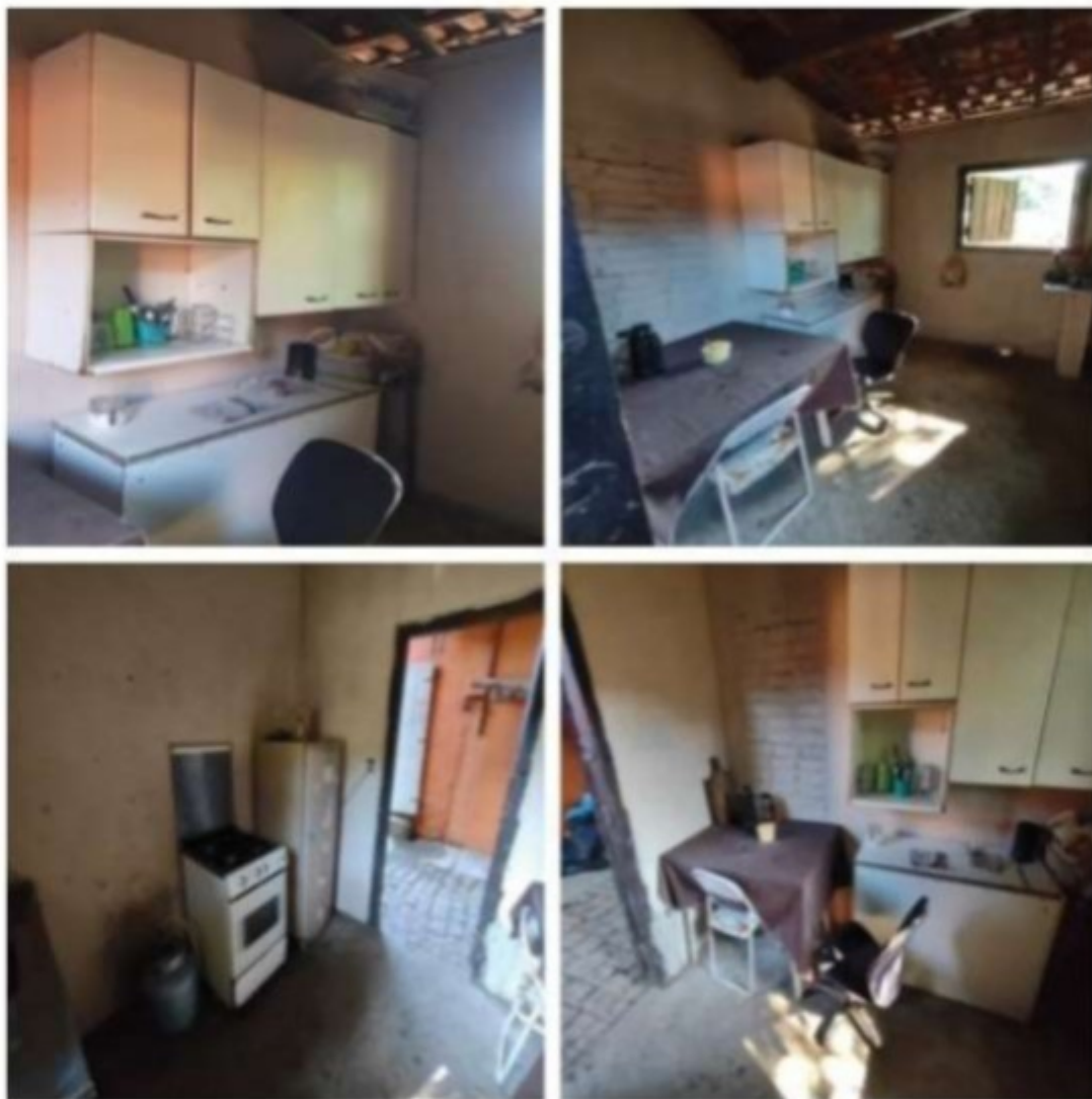
Fotos 66 a 69: Fotos do local em que os trabalhadores [REDACTED] preparavam e tomavam as refeições.
