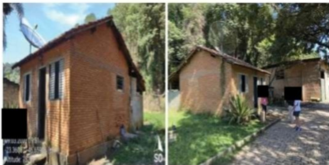
Fotos 113 a 114: Fotos do exterior da casa onde vivia o trabalhador [REDACTED]. Casa em boas condições. [REDACTED] não foi resgatado, pois estava em uma condição diferente dos demais trabalhadores
