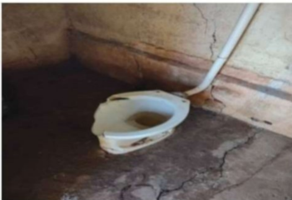
Figura 5: vaso sanitário com bacia quebrada e sem tampo.
