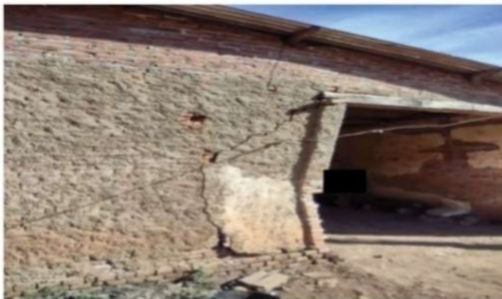
Figura 1: parede do galpão com rachaduras visíveis.
