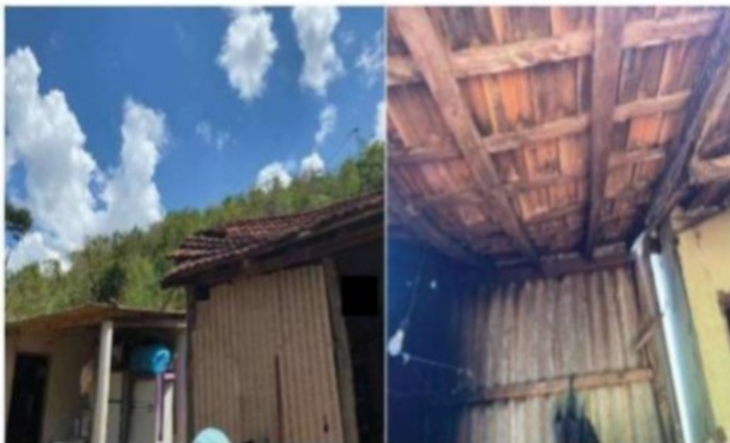
Figura 12 e 13: telhado com risco de desabamento em moradia familiar.
