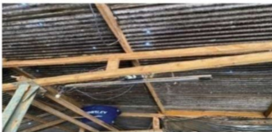
Figura 3: instalações elétricas inadequadas no interior do galpão.
