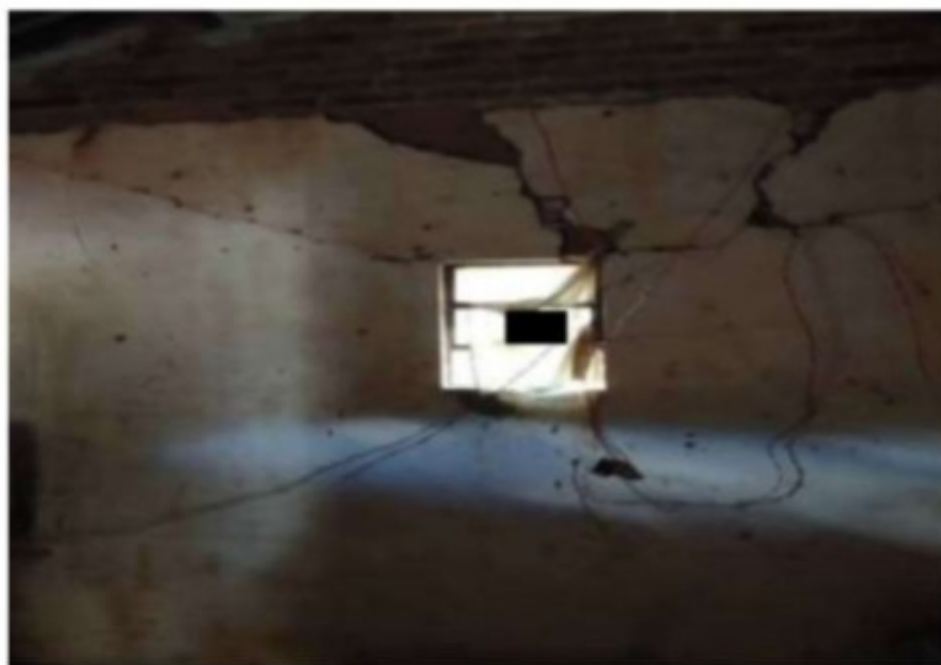
Figura 8: janela sem vidros e fiação elétrica precária no alojamento
