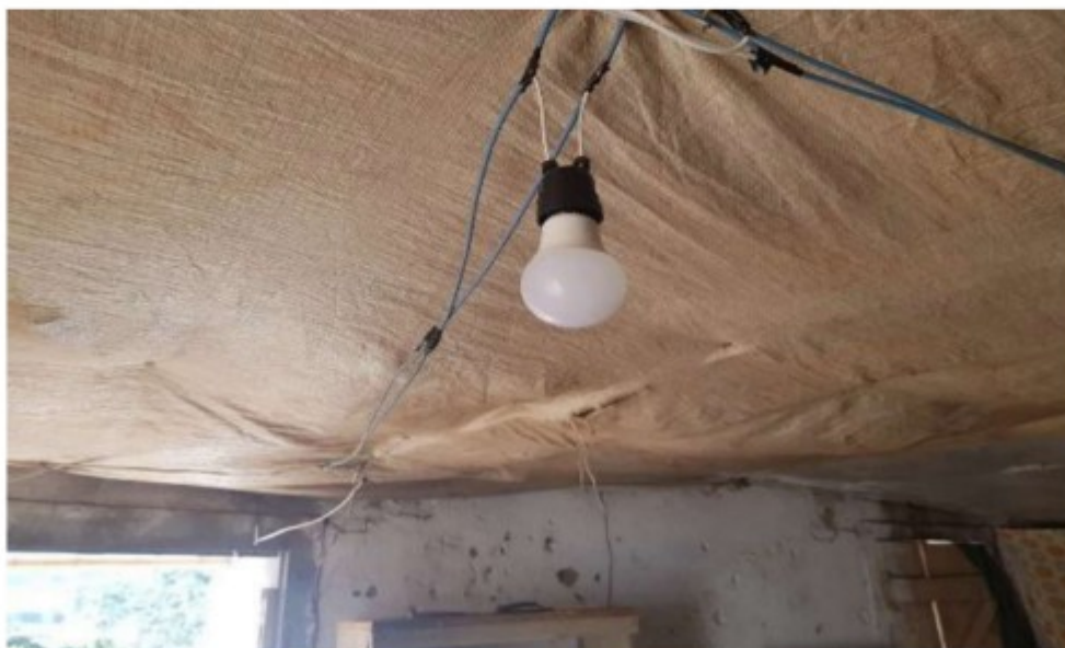
Foto 54: Detalhe das Instalações elétricas no cômodo ocupado por [REDACTED] no teto vemos uma lona plástica na qual está fixada a instalação elétrica.
