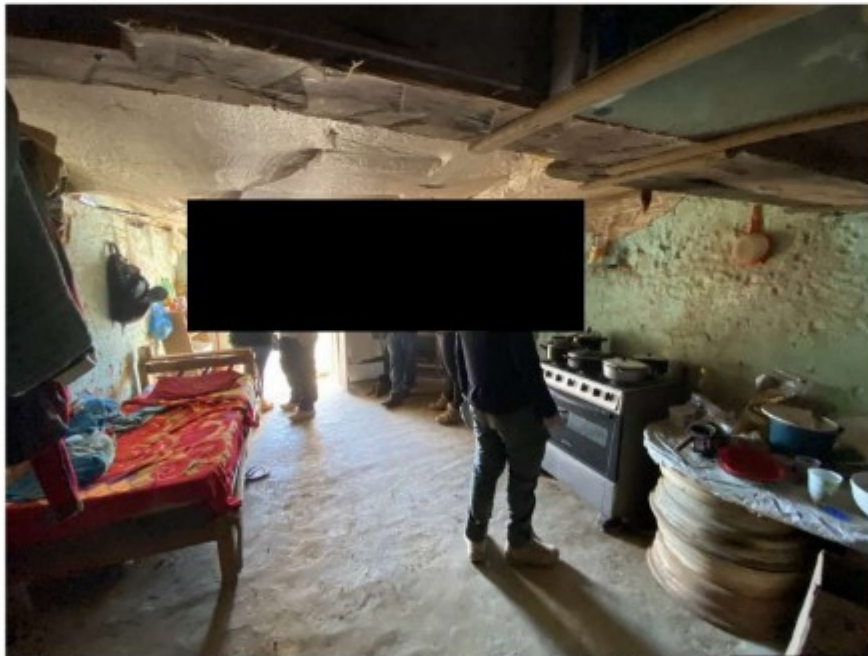
Foto 12: Interior do quarto onde estavam alojados os trabalhadores e seu filho de 16 anos de idade e o trabalhador. O pé direito tem aproximadamente 2m de altura e é de taboado de madeira sobre o qual há terra batida. Os trabalhadores improvisaram um forro com lona encerada para evitar que continuasse caindo poeira vinda de cima.
