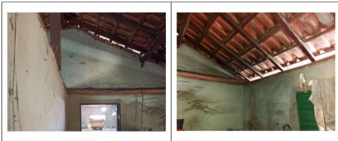
Nas madeiras que sustentavam o telhado, ao longo das paredes e por sobre as divisões dos cômodos havia muitos fios energizados, com emendas expostas e em arranjos totalmente improvisados, sem o devido isolamento, caracterizando "gambiarras" elétricas, o que tornava evidente e acentuado o risco choques elétricos e incêndios.
