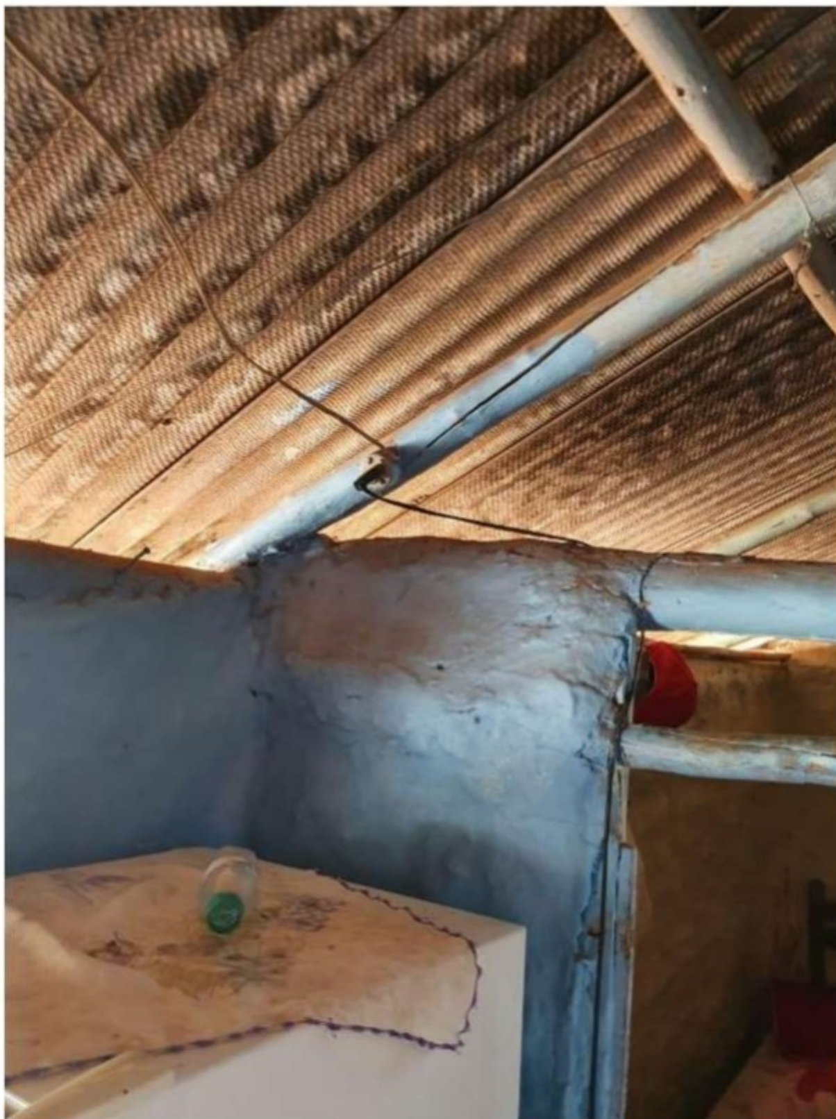
Figura 5 foto da moradia do casal, onde é possível notar a precariedade das instalações elétricas e o vão existente entre o telhado e as paredes
