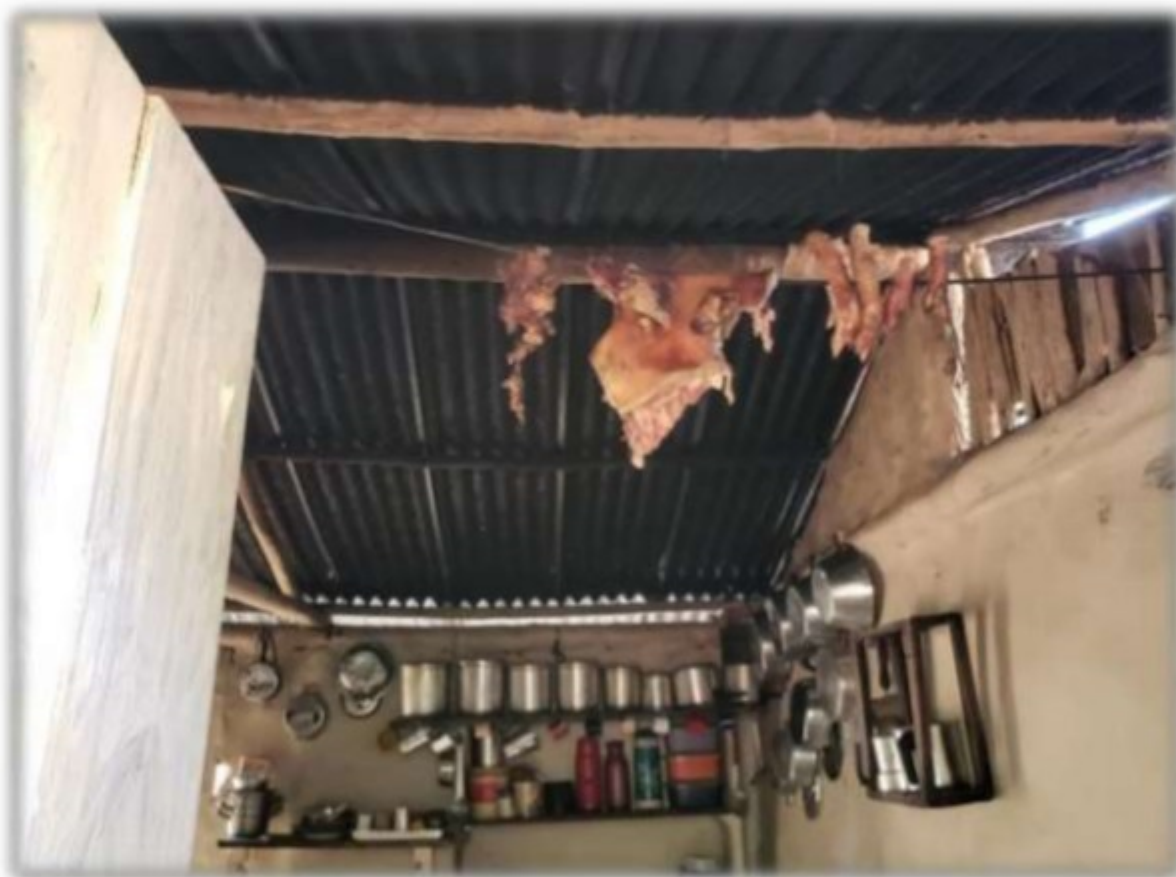
Figura 6 varal armazenando carne de forma inadequada
