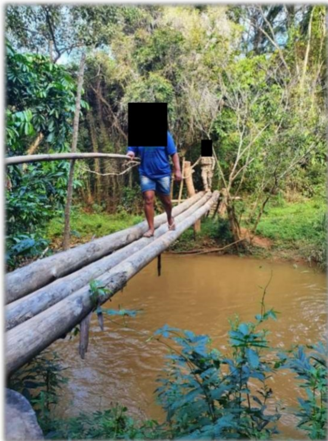
Figura 4 ponte improvisada que os trabalhadores tinham que atravessar diariamente
