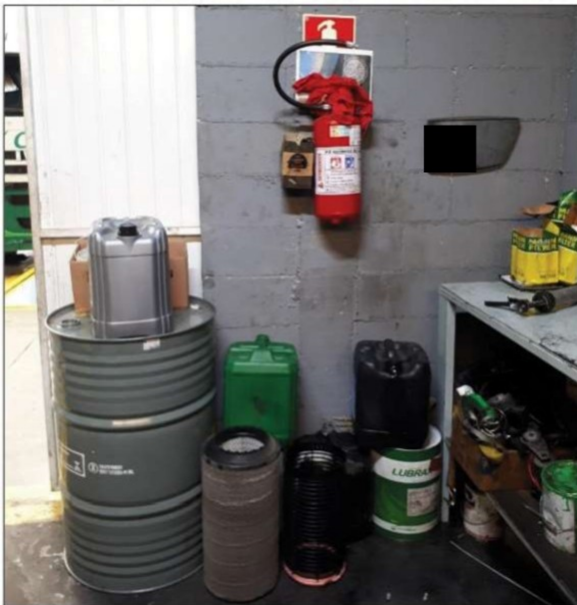
Imagem: Extintor de incêndio que ficava na sala denominada “Lubrificantes” estava obstruído por embalagens de óleo e outras coisas.
