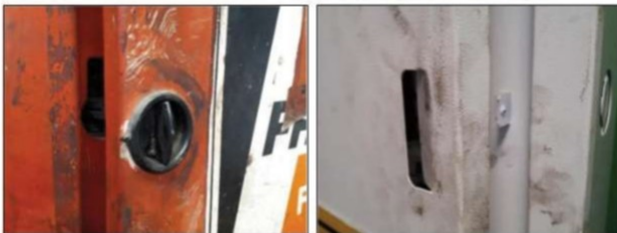
Imagens: Fechaduras dos quadros de distribuição de energia encontrados na borracharia. Não havia cadeados ou trancas.
