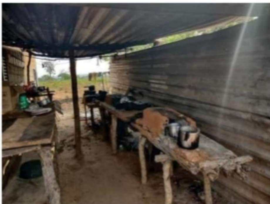
Foto 24: Local onde ficavam os fogões a lenha, não havia portas em duas laterais e uma das laterais foi fechada de forma improvisada com telhas de metal, piso de chão batido.
