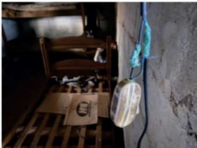
Foto 52: Fiação elétrica improvisada, emendas feitas com material impróprio
