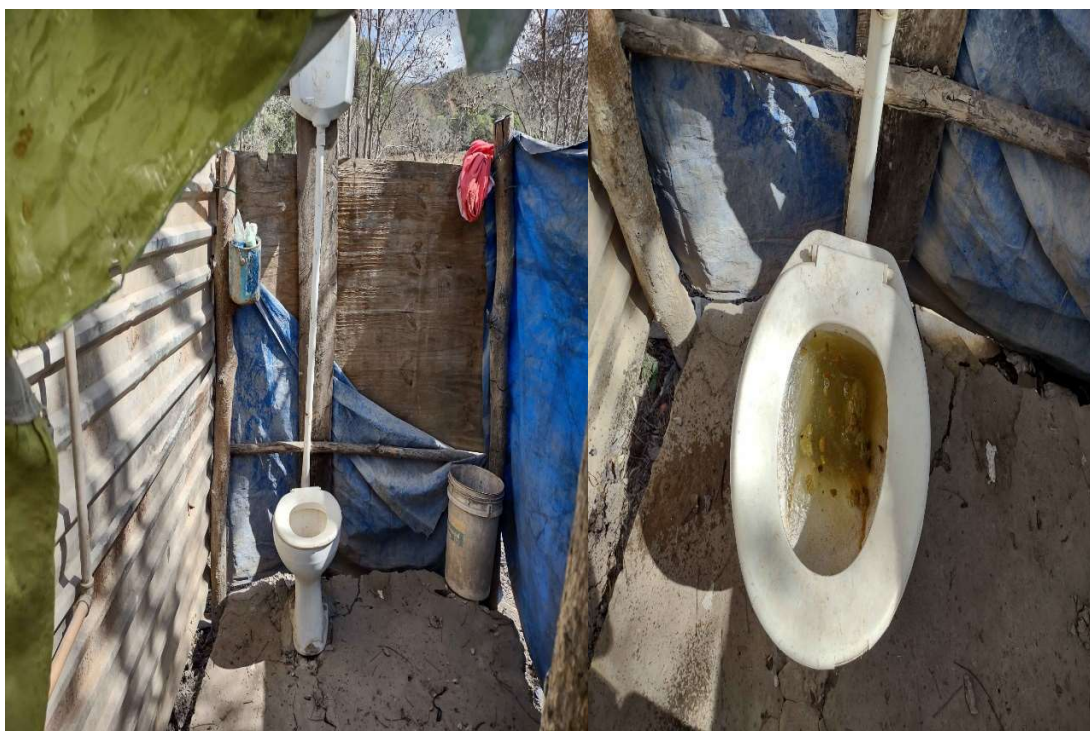
Figura 20: Visão do vaso sanitário com a caixa de descarga no interior da estrutura improvisada;
