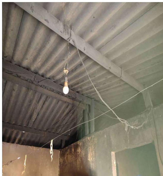
Figuras 25 e 26: Soquetes de lâmpadas pendendo do teto e emaranhados de fiação exposta no exterior e no interior da casa do trabalhador.
