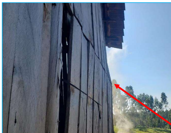
Imagens: As paredes do galpão estavam tortas e escoradas por troncos de eucalipto.
