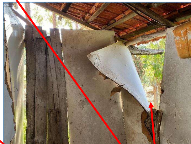
Imagens: Instalações sanitárias da Carvoaria. Eram visíveis os caibros rachados no telhado e as aberturas nas paredes .
