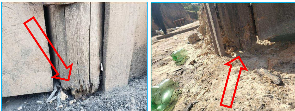
Imagens: As madeiras de sustentação da estrutura estavam corroídas em sua base, sendo que uma delas já nem mais tocava o chão.
