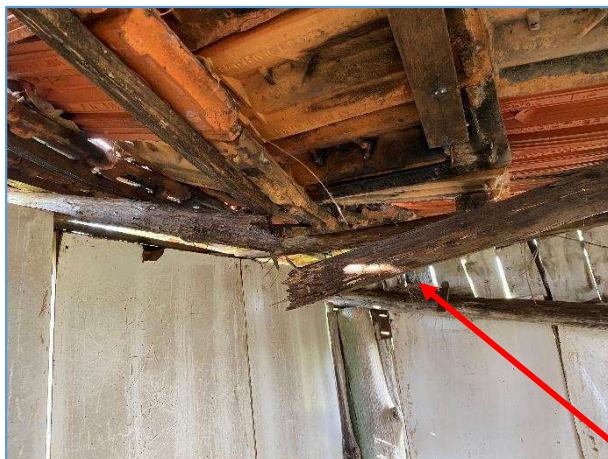
Imagens: Instalações sanitárias da Carvoaria. Eram visíveis os caibros rachados no telhado e as aberturas nas paredes .
