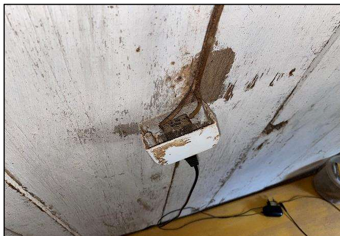
Imagens: Instalações elétricas precárias dos alojamentos.
