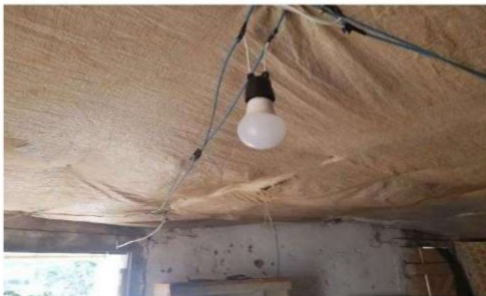
Foto 54: Detalhe das Instalações elétricas no cômodo ocupado por no teto vemos uma lona plástica na qual está fixada a instalação elétrica.
