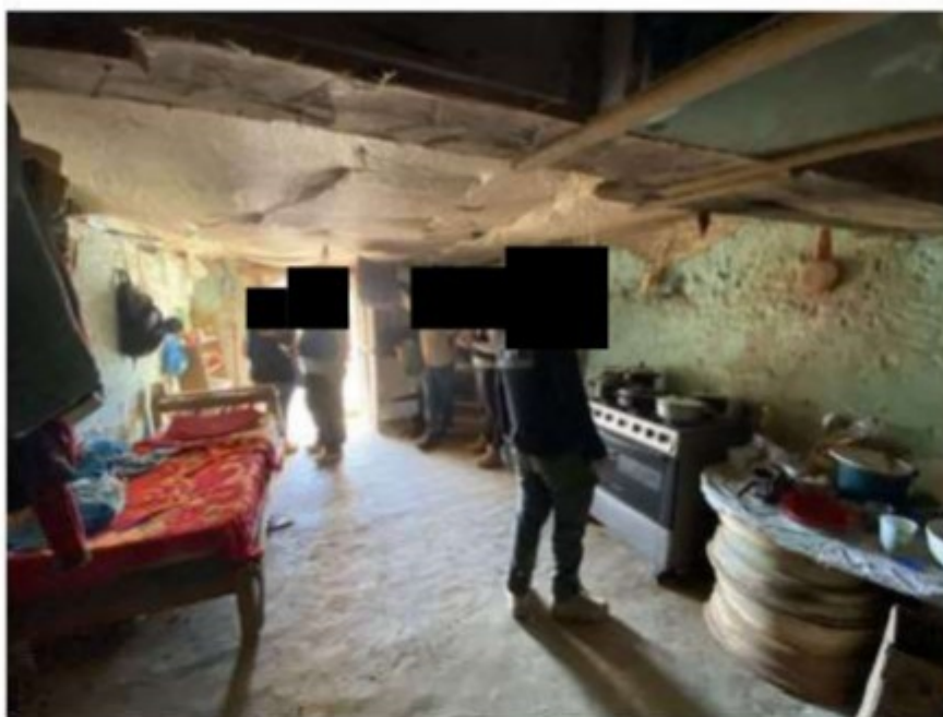
Foto 12: Interior do quarto onde estavam alojados os trabalhadores e seu filho. O pé direito tem aproximadamente 2m de altura e é de taboado de madeira sobre o qual há terra batida. Os trabalhadores improvisaram um forro com lona encerada para evitar que continuasse caindo poeira vinda de cima.
