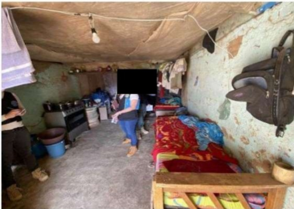
Foto 51: instalações elétricas mantidas com risco de choque elétrico ou outros tipos de acidente (descumprimento dos itens 31.22.1 e 31.22.2 da NR-31). A fiação elétrica não estava acondicionada em eletrodutos e estava afixada no teto no qual havia uma lona, podendo causar um evento incendiário.
