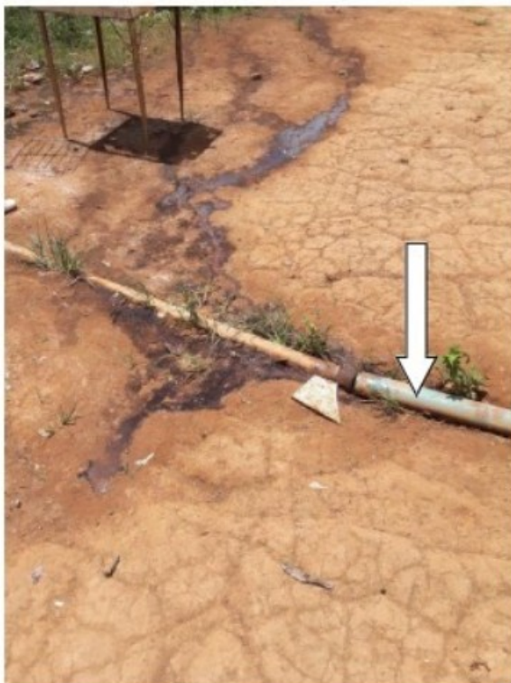
FOTO 30 – Detalhe: tubulação de descarga do lavatório.
