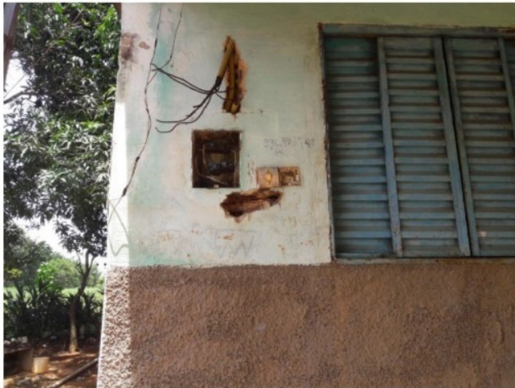
FOTO 41 – Detalhe: disjuntores e fiação elétrica com partes expostas.
