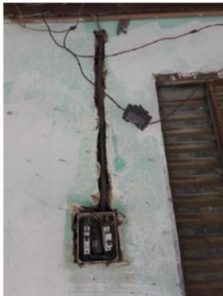
FOTO 41 – Detalhe: disjuntores e fiação elétrica com partes expostas.
