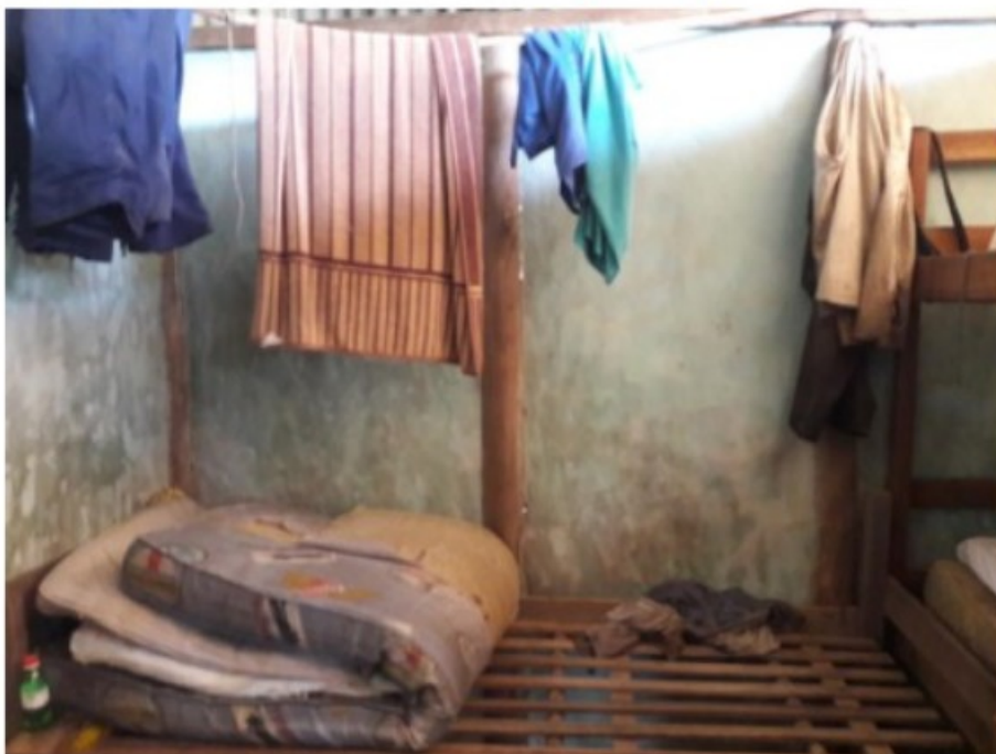
FOTO 14 – Vista de uma das camas e da parede apresentando mofo.
