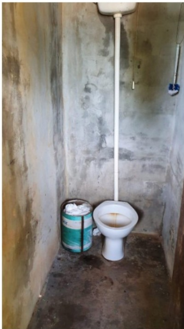
FOTO 21 – Vaso sanitário. Detalhe para o piso e paredes.
