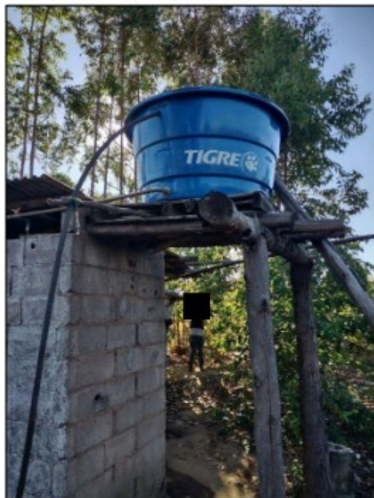
Foto 29: caixa d'água próximo à instalação sanitária a qual era abastecida a partir de uma bomba d'água que bombeava a água do tanque pipa.
