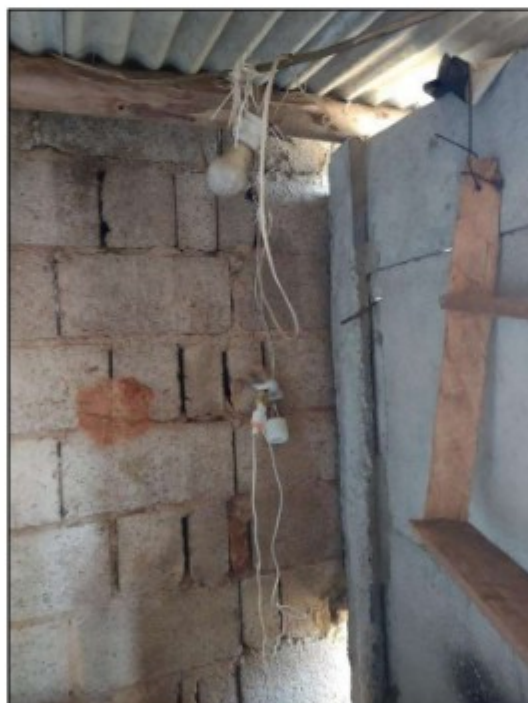
Fotos 30, 31 e 32: instalações elétricas mantidas com risco de choque elétrico ou outros tipos de acidente (descumprimento dos itens 31.22.1 e 31.22.2 da NR-31).
