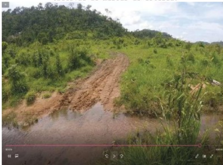
Sangradouro da barragem. Novamente observar as marcas de esteira.
