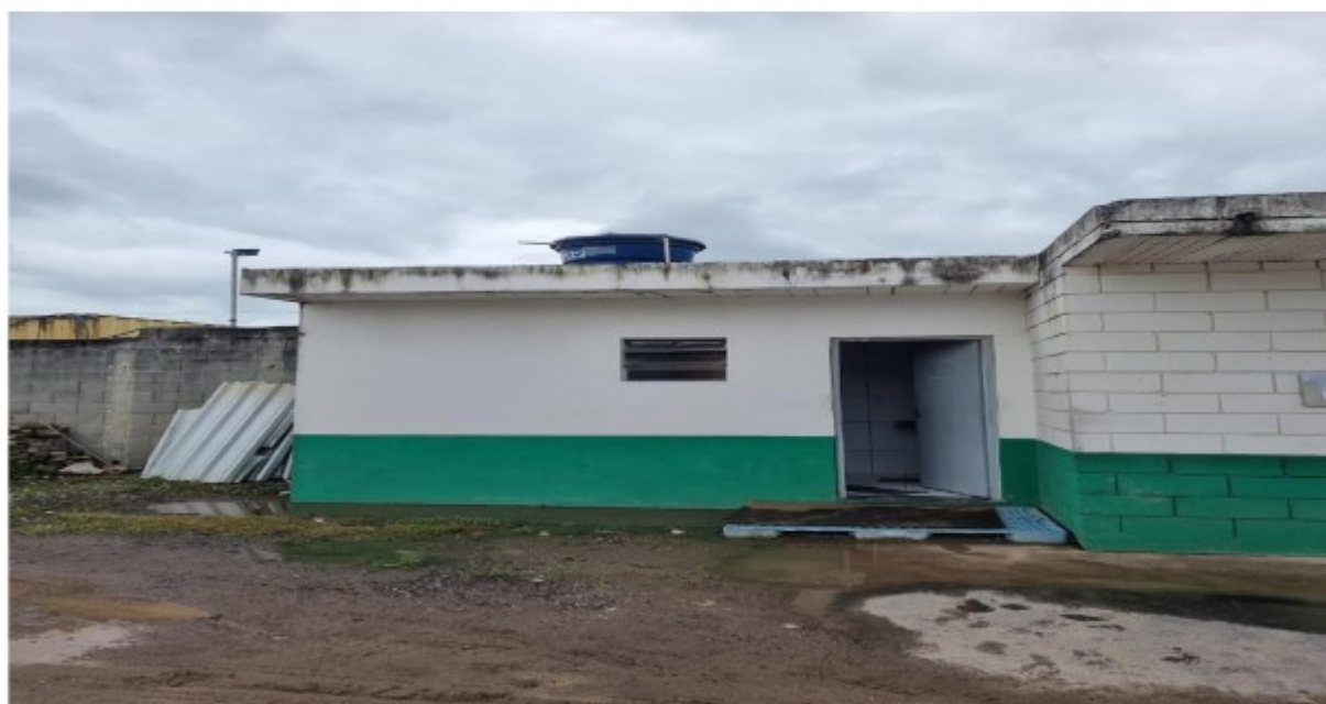
Foto 16: PÁTIO/GARAGEM da empresa TRANSPORTADORA SIDER. Única instalação sanitária existente no local de espera, de repouso e de descanso dos motoristas profissionais empregados da empresa, utilizada por homens e mulheres. Dentro da única estrutura havia 1 (um) lavatório, 1 (um) vaso sanitário e 1 (um) chuveiro.
