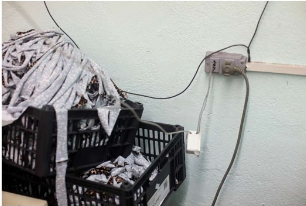
Foto 24: Material de fácil combustão em contato direto com as “gambiarras” elétricas.
