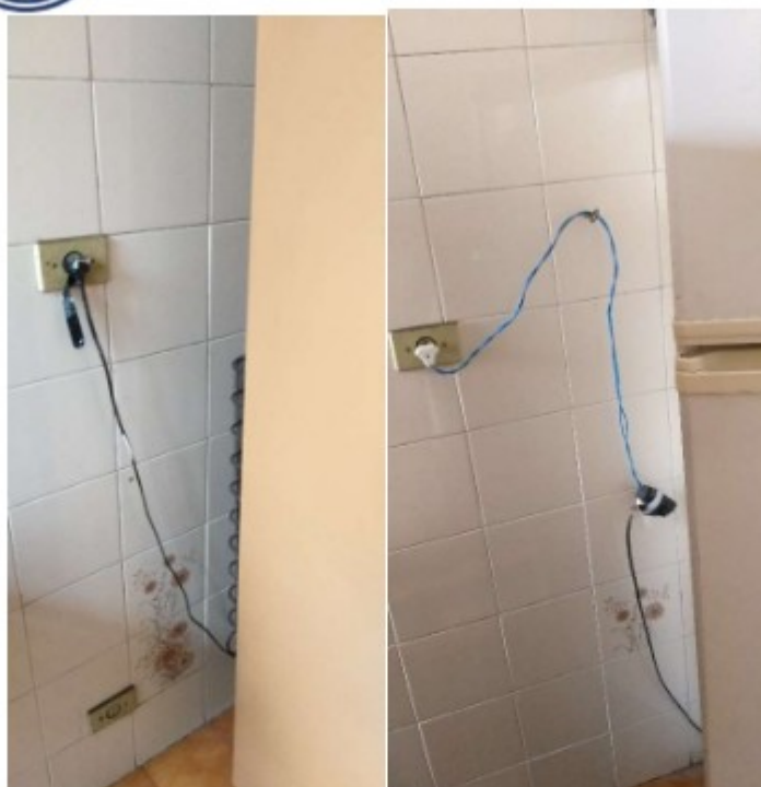
Fotos 40 e 41 – instalações elétricas precárias em área de vivência (cozinha)
