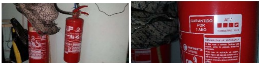
Fotos 36 e 37 – dois únicos extintores no imóvel, usados como suporte para roupas, descarregados e com manutenção vencida desde o final de 2018.
