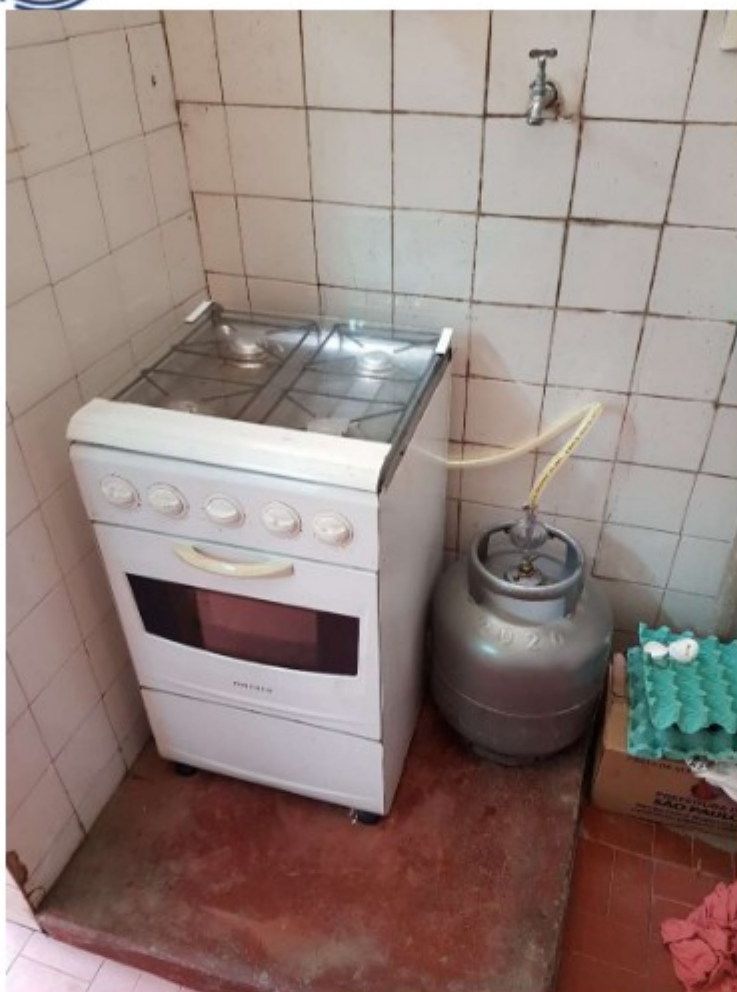
Fotos 38 e 39 – botijões de GLP em ambiente fechado e sem ventilação. Risco de explosão e incêndio.
