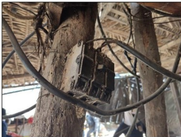
Imagens: Detalhes das instalações elétricas que ficavam dentro de um dos barracos e serviam para alimentar as máquinas utilizadas na mina e os eletrodomésticos, como geladeira.
