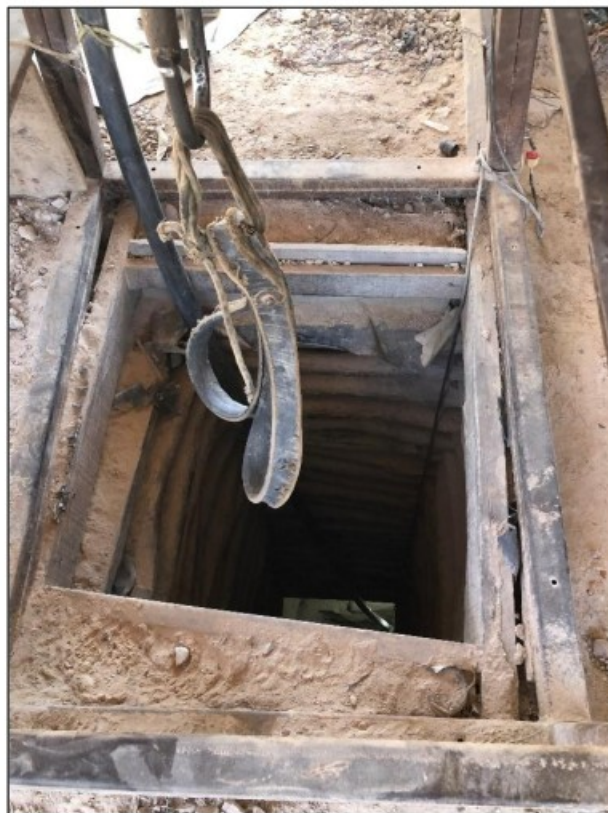
Imagens: Detalhes da abertura do poço da mina, sem qualquer proteção ou sinalização que prevenisse queda de trabalhadores.
