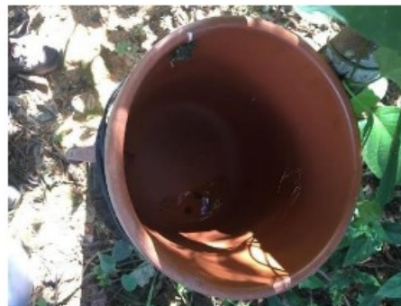
Bombona Utilizada para armazenar água consumida no alojamento /O filtro estava seco e com teia de aranha em seu interior
