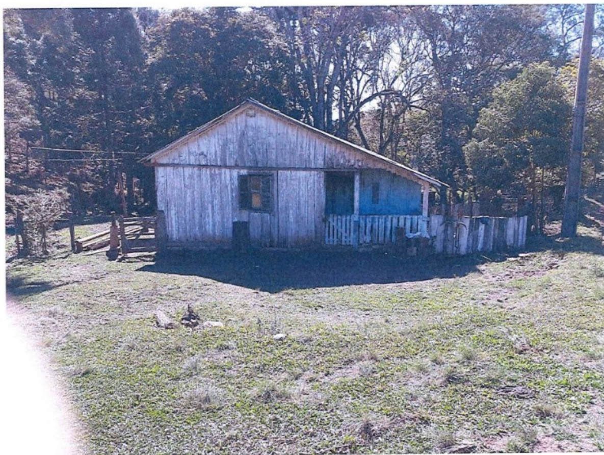
Foto 19 – Foto da moradia do empregado [REDACTED] demonstrando desgaste das tábuas de madeira, inclusive, para algumas delas, com buracos (frestas) em suas partes inferiores, que permitiam a entrada de animais peçonhentos e prejudicavam, notadamente na época de frio, o conforto térmico dentro da casa.
