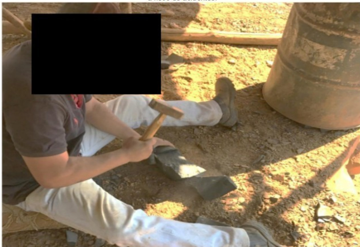
Imagem 14 – Trabalhador quebrando pedra sem fazer uso de equipamentos de proteção individual, como luvas e óculos, exposto a risco de acidentes, principalmente por estilhaços nos ossos.
