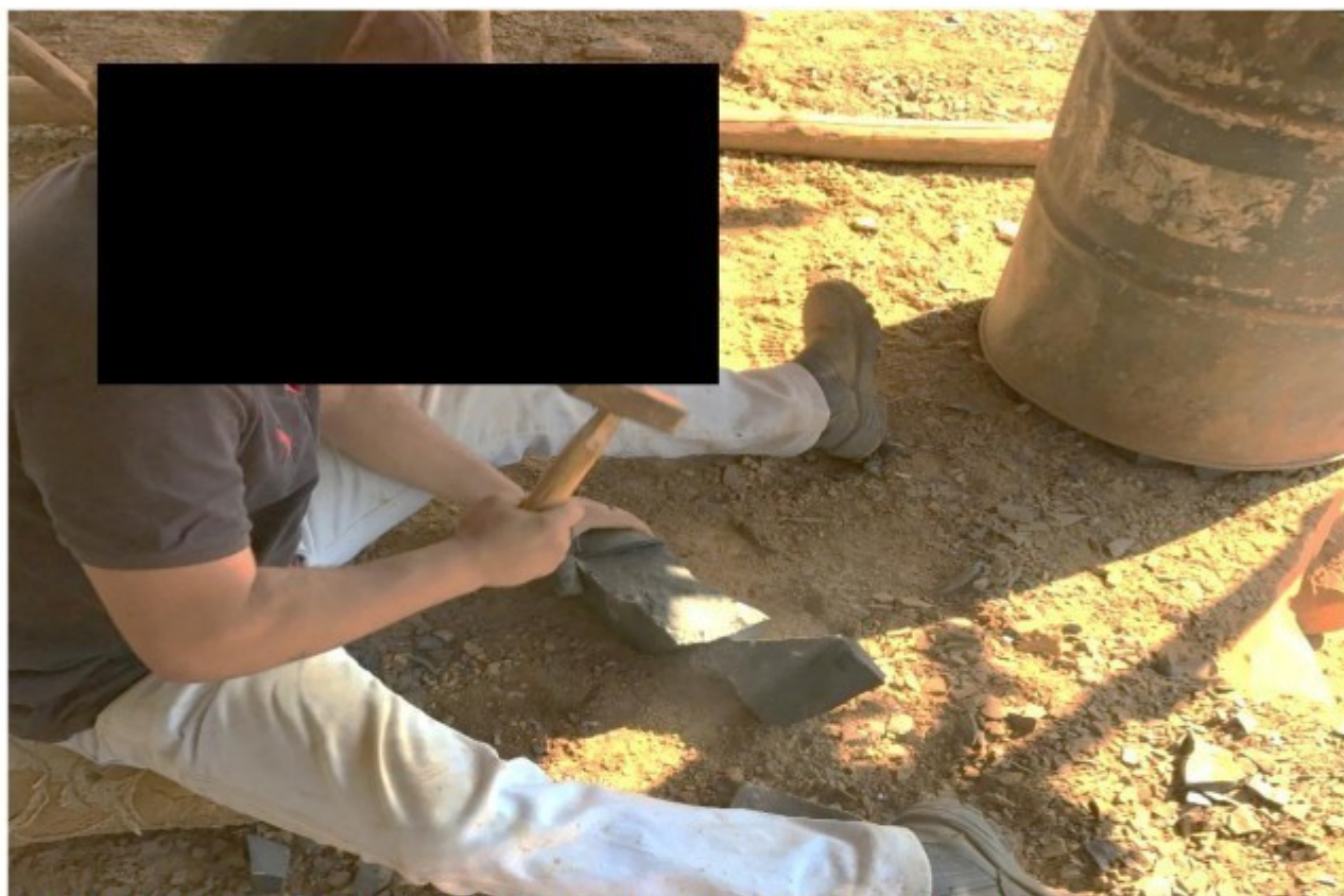
Imagem 22 – Trabalhador quebrando pedra sem fazer uso de equipamentos de proteção individual, como luvas e óculos, exposto a risco de acidentes, principalmente por estilhaços nos olhos.
