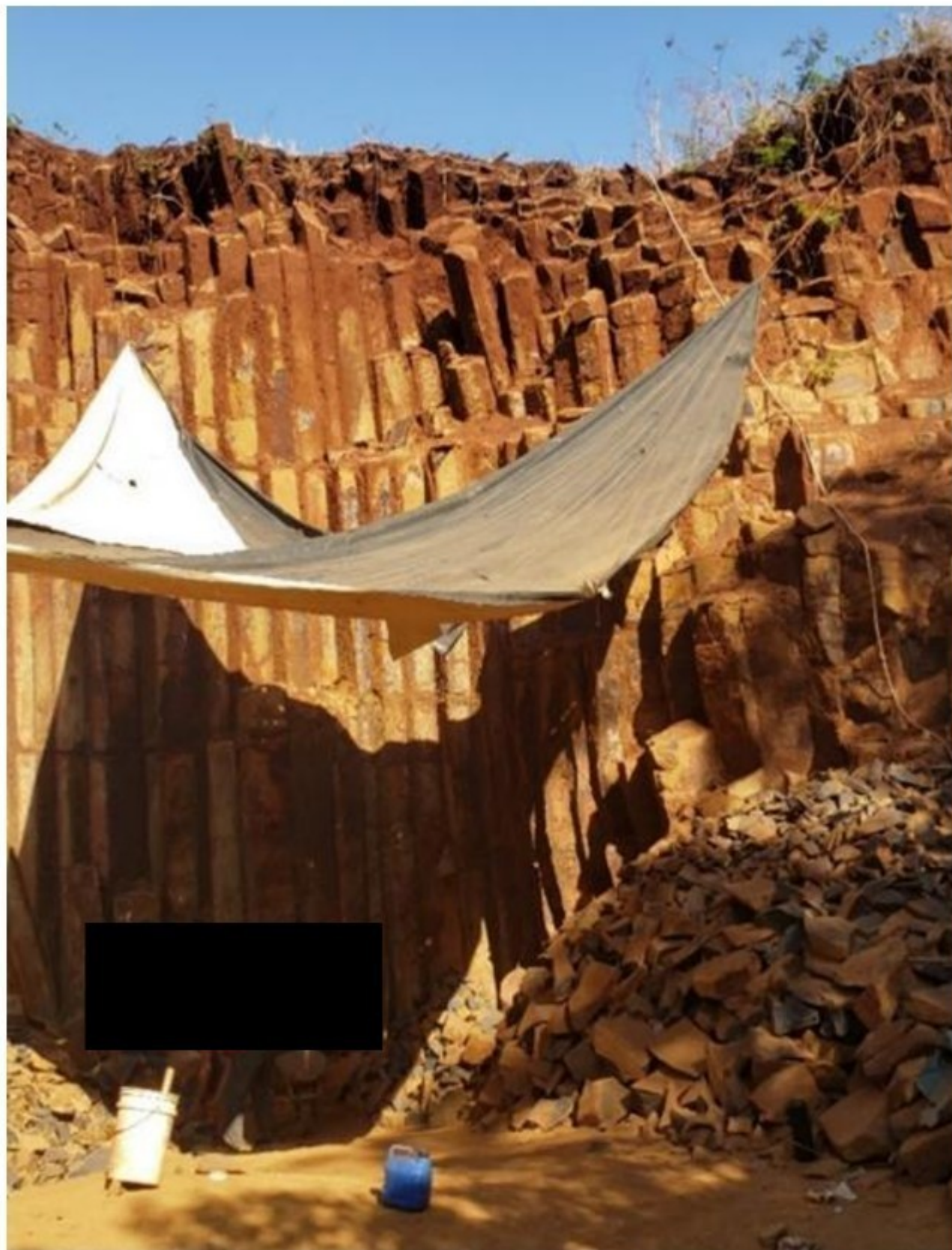
Imagem 24 – Bancada com risco de queda de rochas soltas sobre os trabalhadores.
